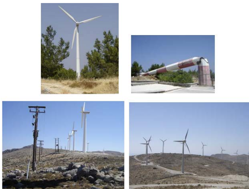
Εικόνα 2.2.6. Πάνω: Εν λειτουργία και κατεστραμμένη ανεμογεννήτρια στη περιοχή Κράτηγου.
