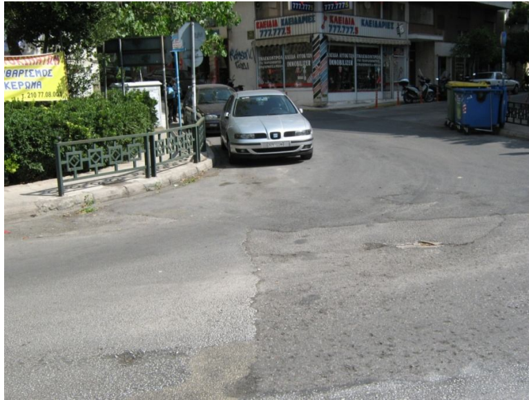
Εικόνα 3.3: Φθορές οδοστρώματος
