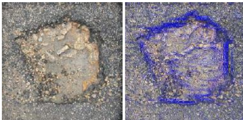
Εικόνα 2.6 : Ορθοφωτογραφία και περίγραμμα λακούβας σε ψηφιακό φωτογραμμετρικό λογισμικό ( Πηγή : Mustaffar et.al, 2008)
