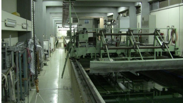
Εικόνα 3.2 Άποψη του φορείου με τον ηλεκτρονικό εξοπλισμό
