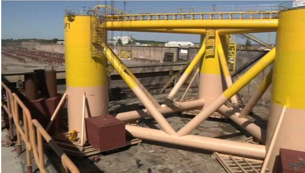
Εικόνα 1.24 Συναρμολόγηση της Windfloat στη στεριά [46]
