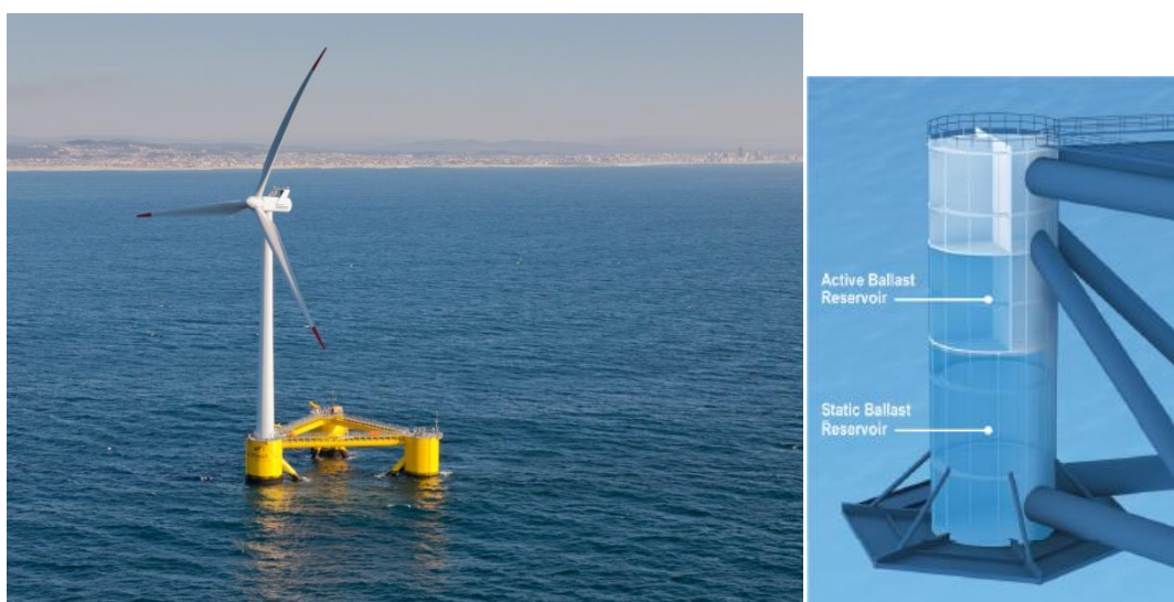
Εικόνα 1.23 Η πλωτή Α/Γ Windfloat και το έρμα στο εσωτερικό ενός κυλίνδρου της [44][45]
