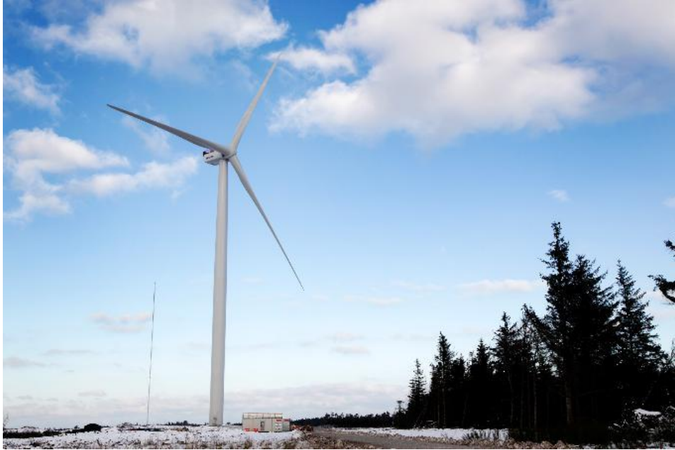
Εικόνα 1.12 Η πρότυπη Α/Γ V164 των 8 MW σε δοκιμαστική λειτουργία [25]
