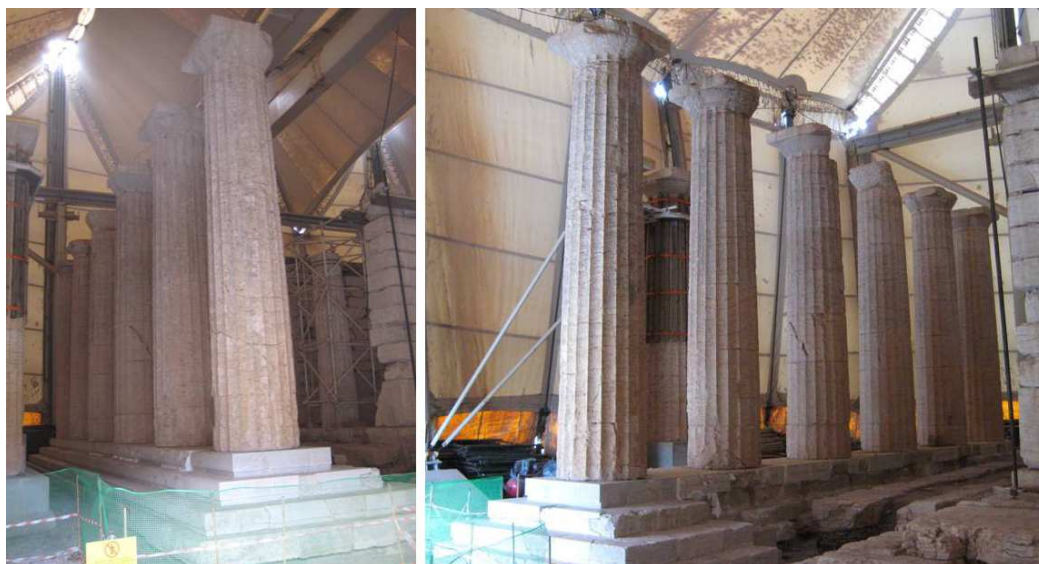
Εικόνα 1.8 Η βόρεια όψη του μνημείου, μετά από την επαναφορά σε αυτό των βόρειων κίωνων του. Απόψεις από βορειοδυτικά (αριστερά) και από νοτιοδυτικά (δεξιά) (Φωτογράφιση: Κωνσταντίνος Παπαδόπουλος). (από τα αρχεία της ΕΣΝΕΑ)
