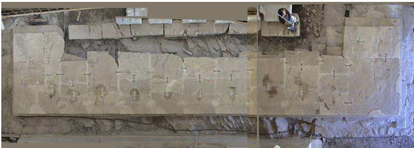
Εικόνα 1.13 Ο πρώτος αναβαθμός της κρηπίδας του βόρειου πτερού του ναού σε κάτοψη μετά από τις εργασίες αποκατάστασής του (Φωτογράφιση: Κωνσταντίνος Παπαδόπουλος).(από τα αρχεία της ΕΣΝΕΑ)
