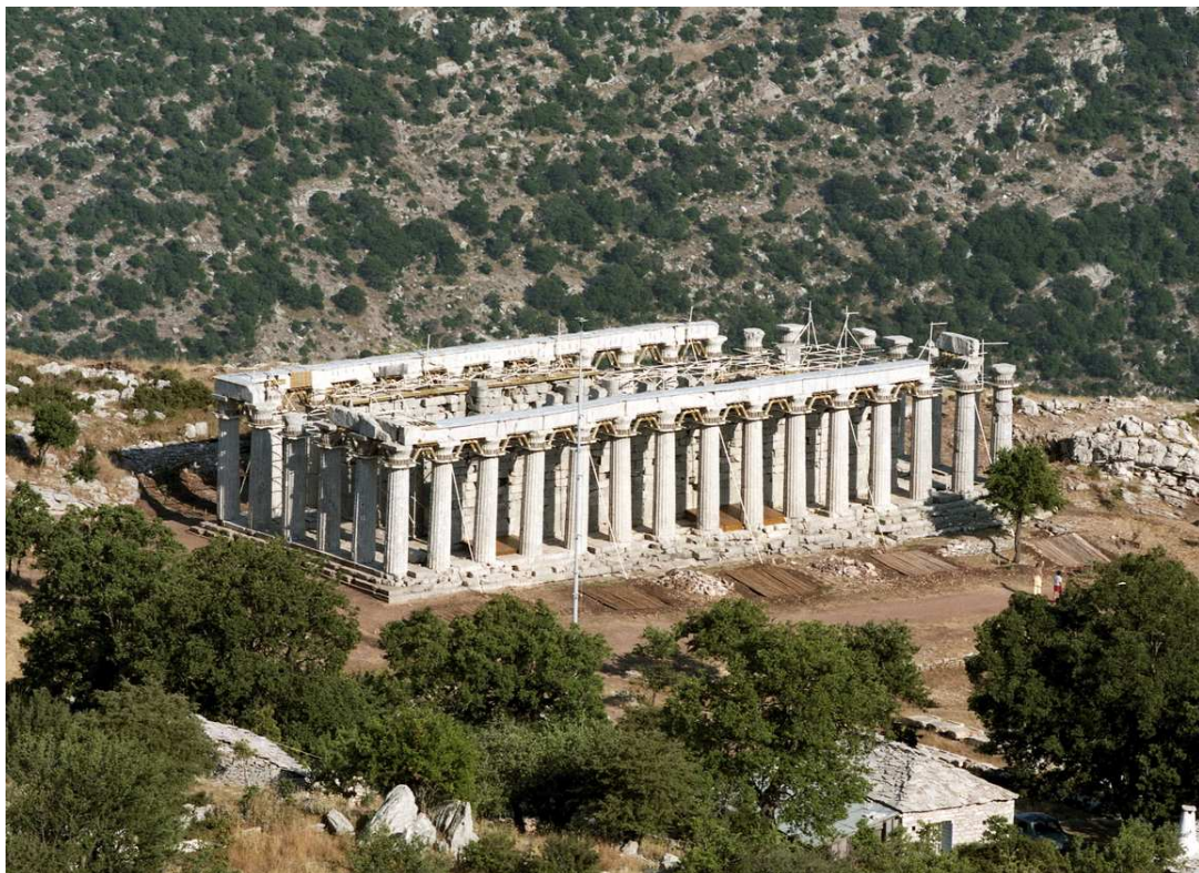
Εικόνα 1.1 Ο ναός του Επικούριου Απόλλωνα, πριν από την έναρξη των εργασιών αποκατάστασής του (Φωτογράφιση: Ι. Ιωαννίδου – Λ. Μπαρτζιώτη). (από τα αρχεία της ΕΣΝΕΑ)
