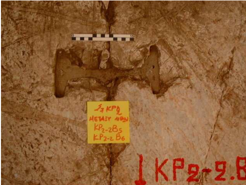
Εικόνα 3.4 Ο σύνδεσμος μεταξύ των λίθων
