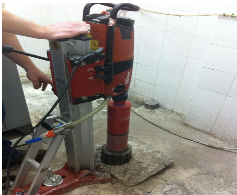
Εικόνα 3.11 Ειδικό μηχάνημα πυρηνοληψίας
