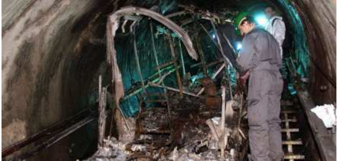
Εικόνα 1.2: Εικόνα καταστροφής της σήραγγας Καπρούν
