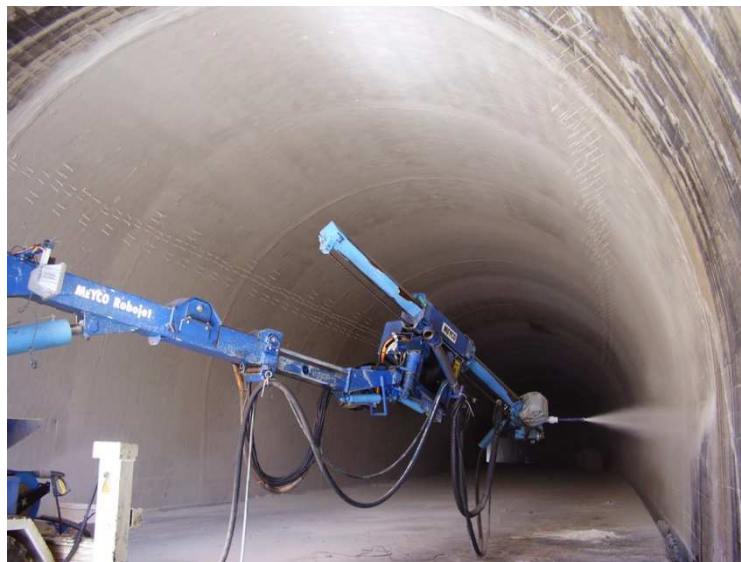
Εικόνα 2.10: Εφαρμογή κονιάματος πυροπροστασίας [55]
