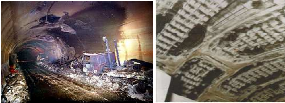
Εικόνα 1.3: Εικόνες από την καταστροφή της σήραγγας της Μάγχης (1996)[11]
