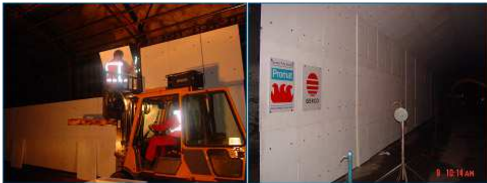
Εικόνα 2.11: Εφαρμογή πλακών πυροπροστασίας [50]
