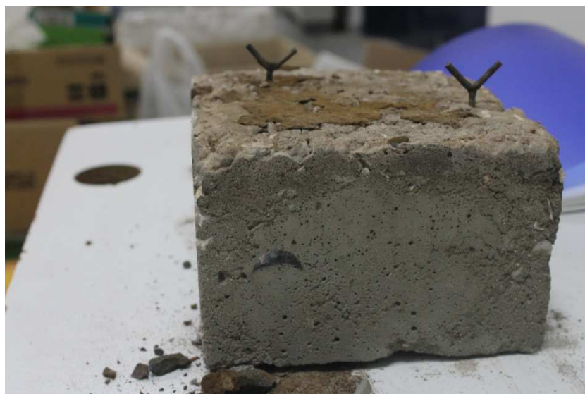
Εικόνα 7.15: Δοκίμιο σκυροδέματος μετά τη δοκιμή παθητικής πυροπροστασίας
