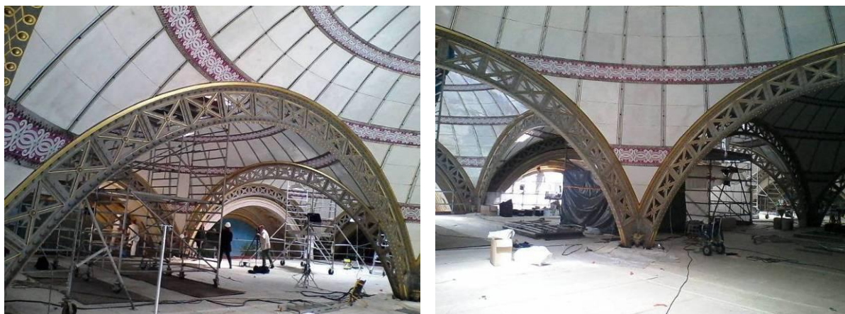
Figure 66 Détail des coupoles de la Salle de Lecture
