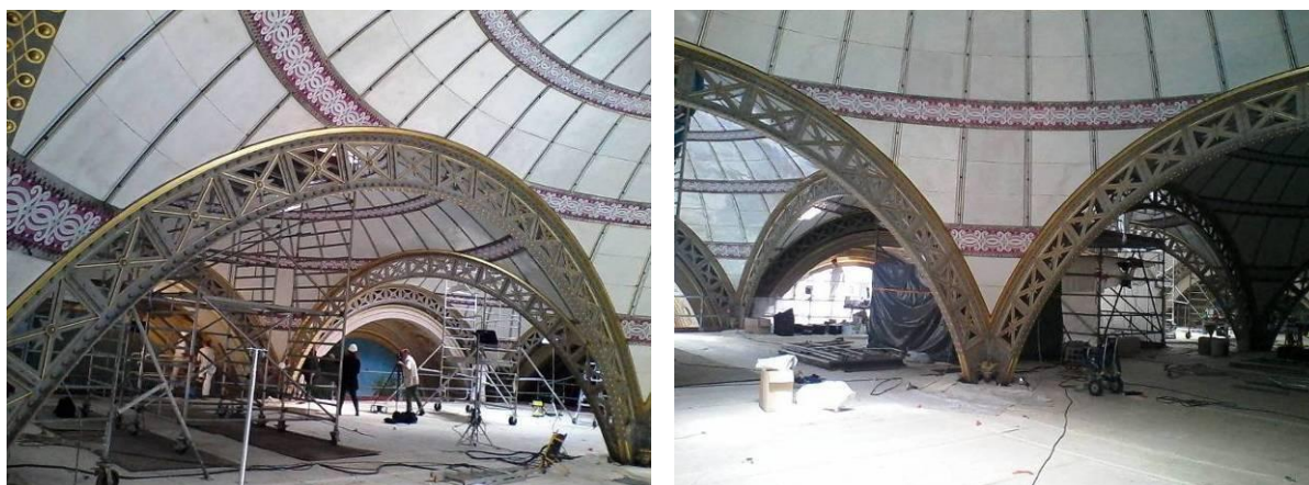
Figure 13 Détail des coupoles de la Salle de Lecture
