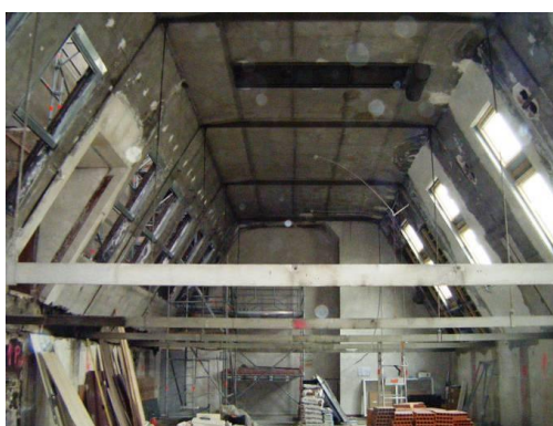
Figure 8 Niveau 12 Magasin Central
