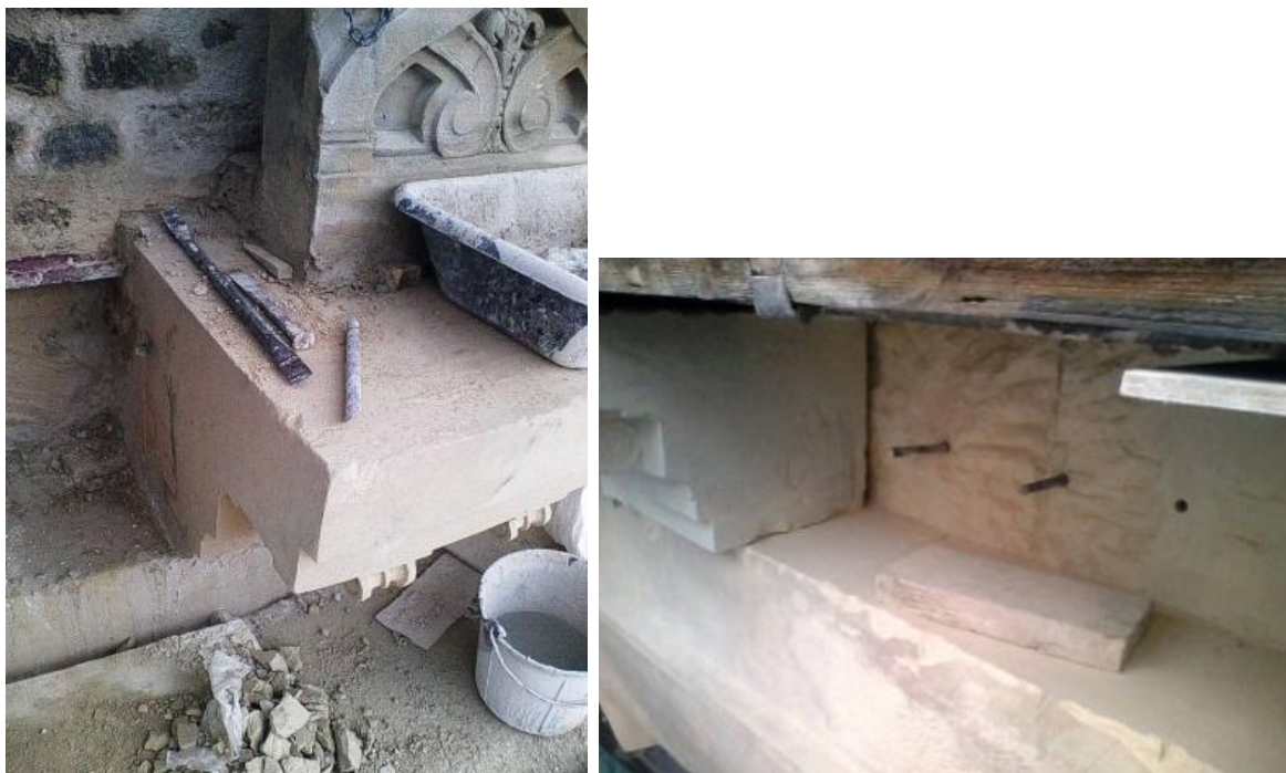
Figure 105 Exemples des défoncements en attente de la pose des blocs des pierres neuves
