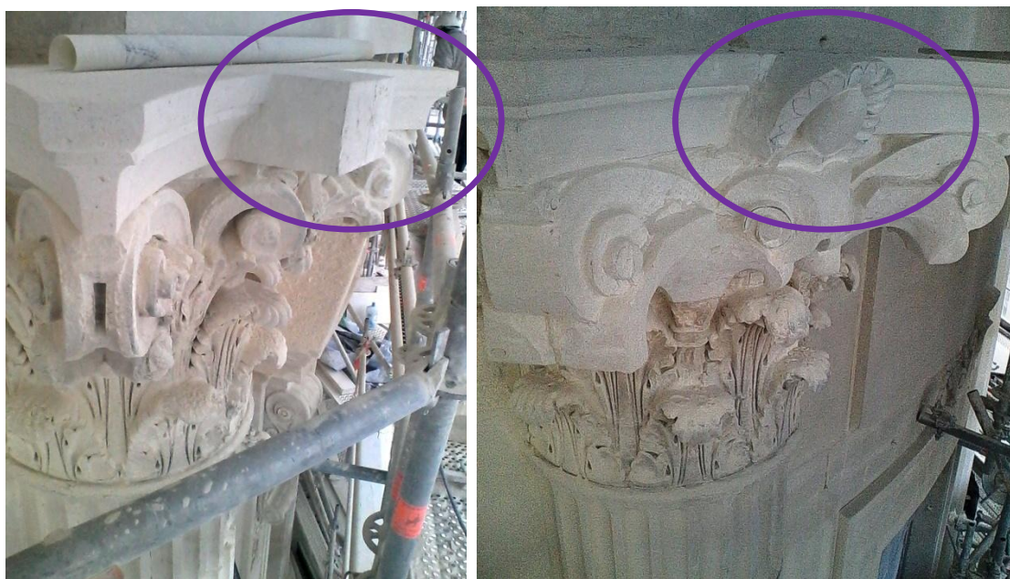
Figure 113 Pose de la pierre neuve et traçage des moulures
