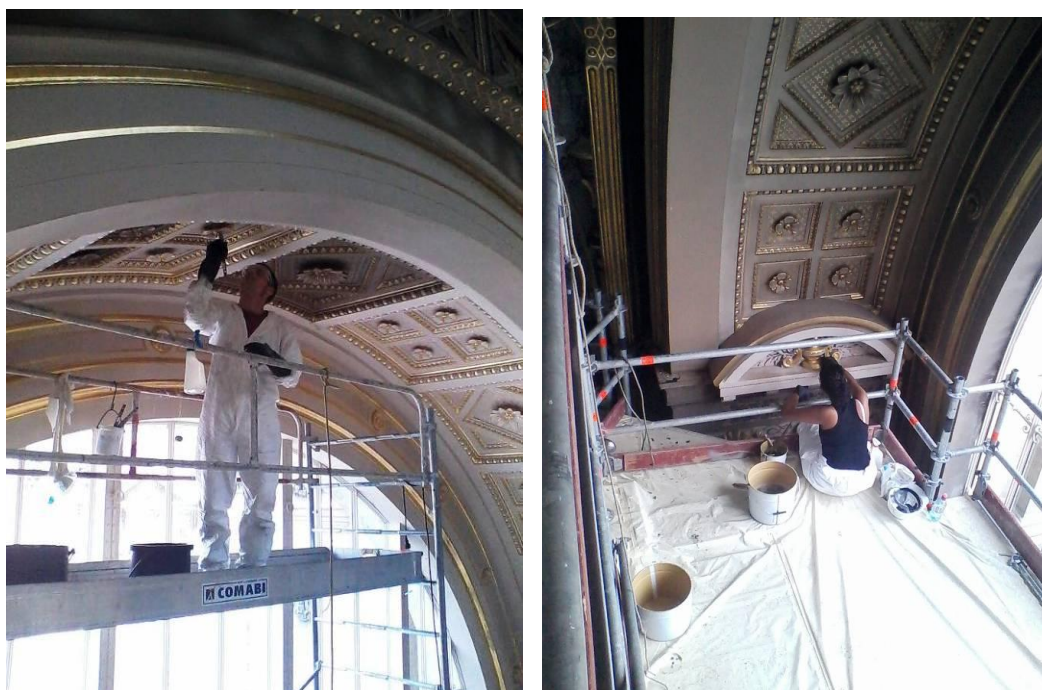
Figure 72 Travaux de nettoyage en cours
