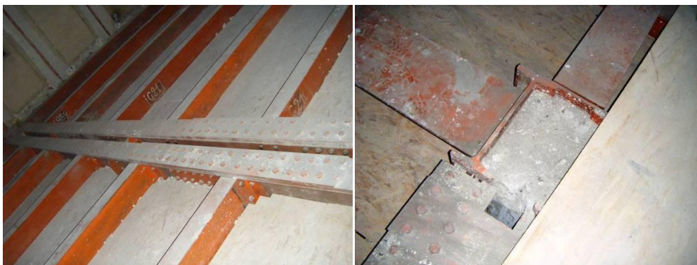
Figure 6 Remplissage des poteaux métalliques en béton pour la stabilité au feu– niveau 12 Magasin Central
