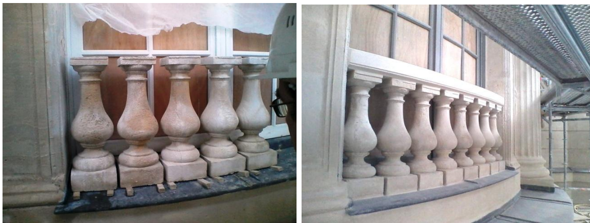
Figure 108 Balustres posés à l'aide des cales de bois et état de finition
