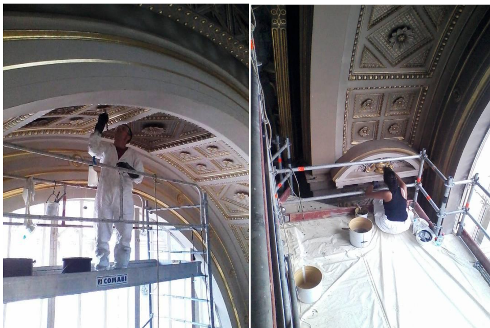
Figure 15 Travaux de nettoyage en cours
