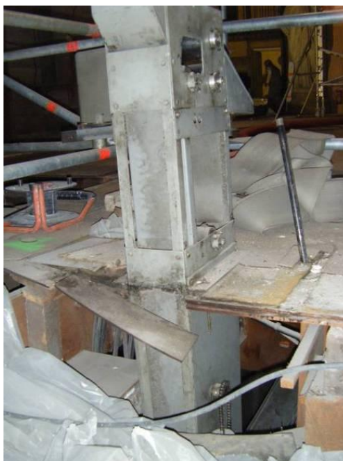
Figure 5 Monte-livre : la machine utilisée pour monter les livres entre les différents salles (salle de lecture et salles des archives/ stockages)
