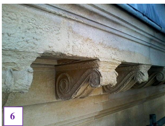
Figure 90 Corniche sous chéneau
