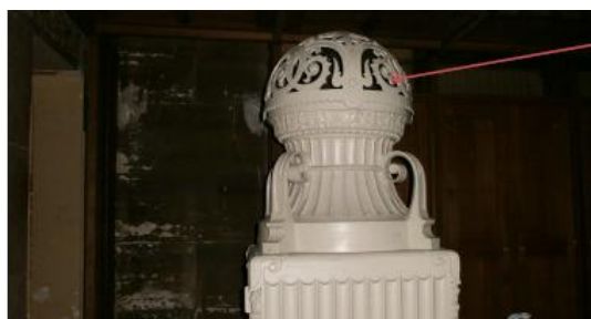
Figure 42 Calorifère: Présence de peinture contenant du plomb
