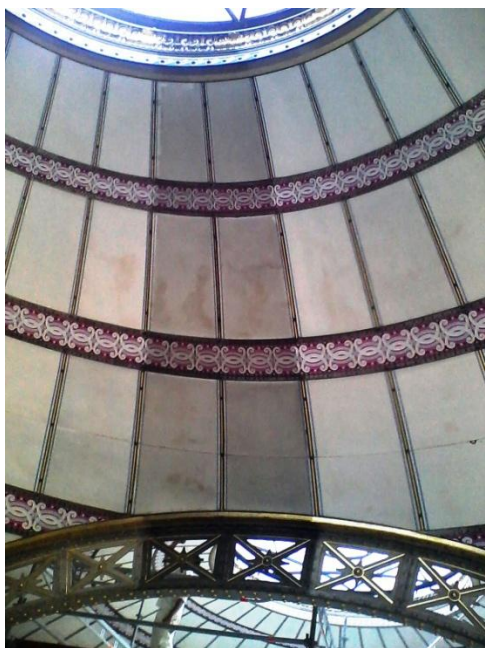
Figure 17 Avant et après nettoyage
