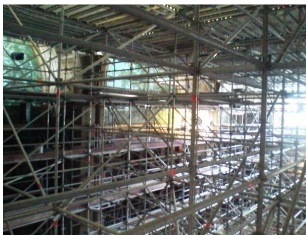
Figure 14 Vue de l'échafaudage dans la Salle Labrouste
