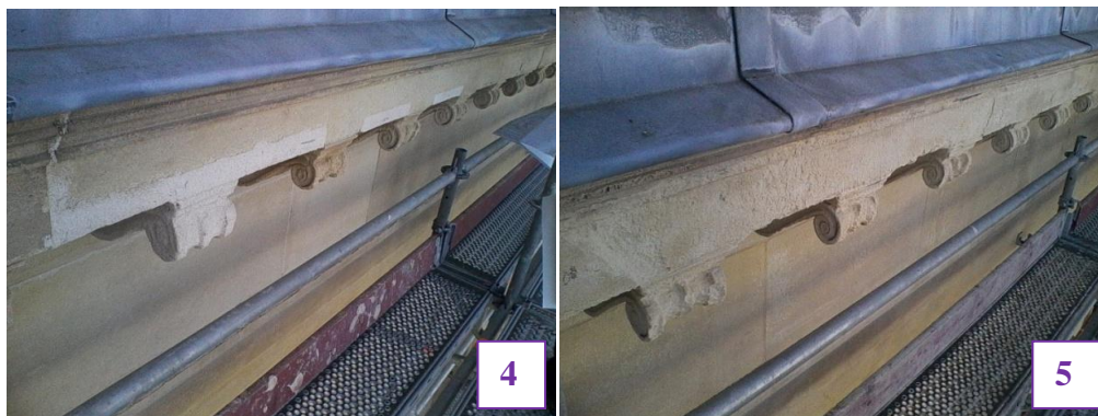
Figure 87 Corniche sous chéneau
