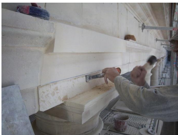
Figure 109 Taille de finition sur un sommier de plate bande posé épannelé.
