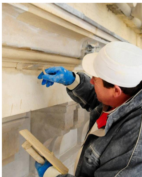
Figure 110 Mise en place d'un ragréage sur corniche.
