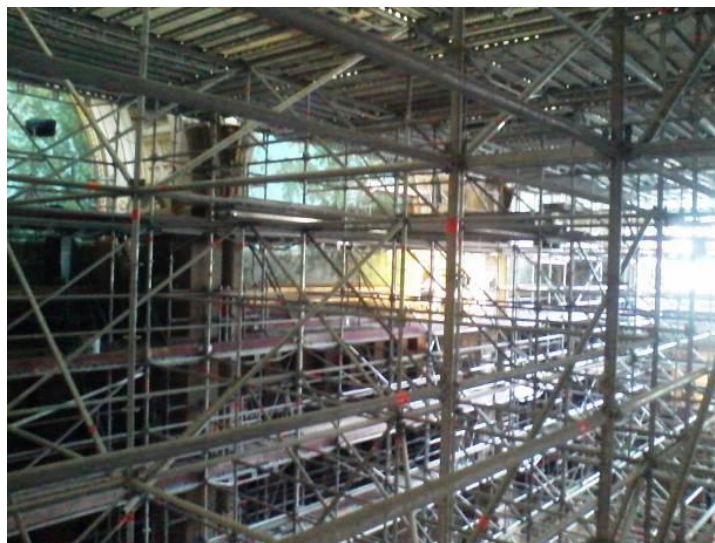
Figure 71 Vue de l'échafaudage dans la Salle Labrouste
