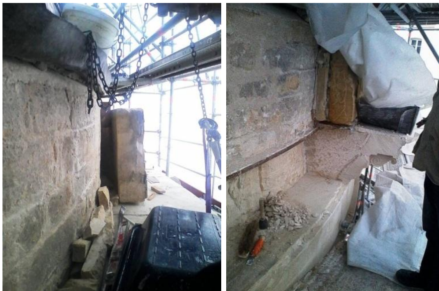
Figure 107 Exemples de pose manuelle de blocs épannelés à l'aide de palans à chaîne.
