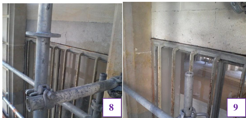
Figure 98 Linteaux en béton
