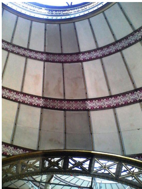
Figure 74 Avant et après nettoyage
