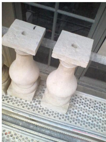
Figure 103 Dépose des balustres en conservation.
