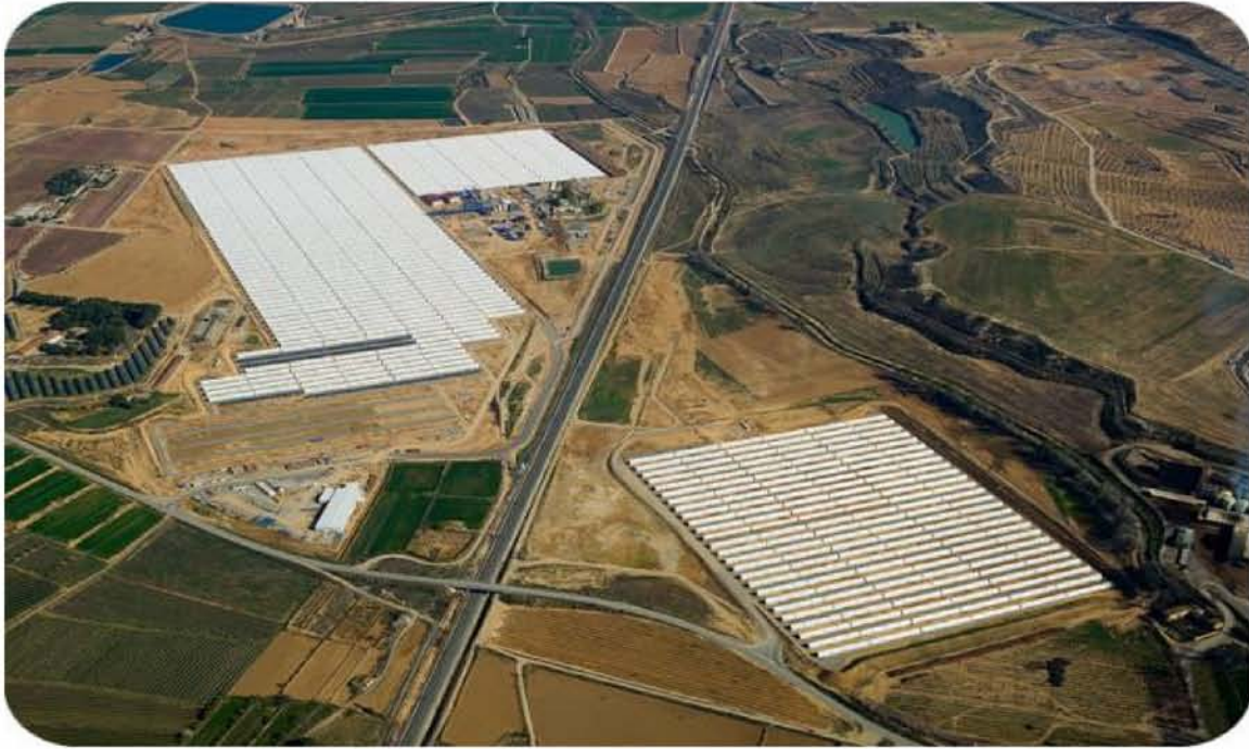
Εικόνα 32. Φωτογραφία του σταθμού Termosolar Borges
