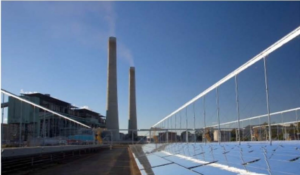
Εικόνα 29. Φωτογραφία του σταθμού Liddell όπου είναι εμφανές τμήμα του ηλιακού πεδίου
