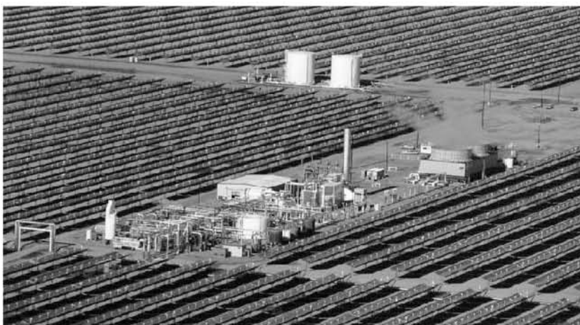
Εικόνα 2. Φωτογραφία του συστήματος ισχύος ενός σταθμού SEGS
