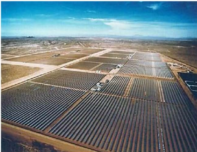
Εικόνα1. Φωτογραφία σταθμού SEGS
