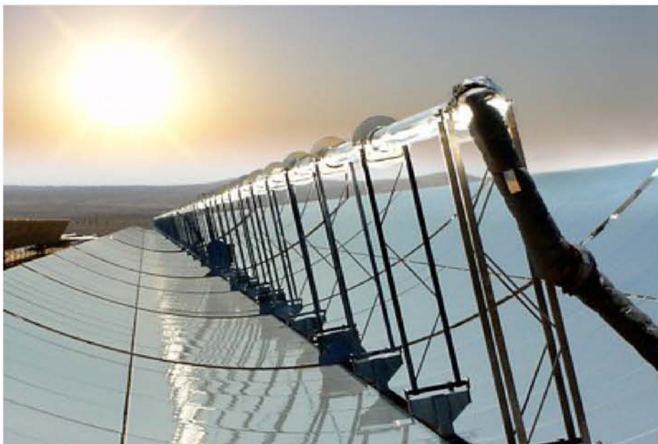
Εικόνα 4. Σειρά καθρευτών, τμήμα του ηλιακού πεδίου
