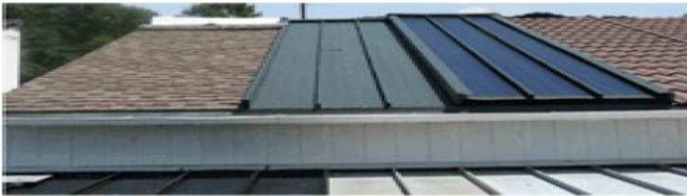
Σχ. 5.1.1.1 Στέγη σκεπασμένη με λεπτές σανίδες, μεταλλική στέγη με υπέρυθρη-αντανακλαστική επίστρωση και μεταλλική στέγη με PV πάνελ με PCM [60]
