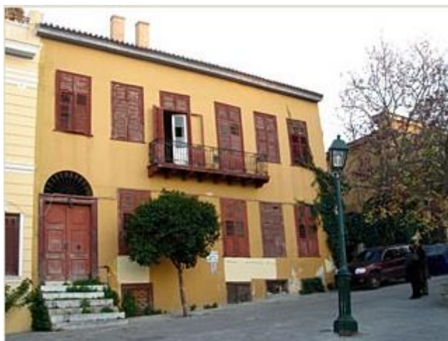
Εικόνα 7-1: Εκτίμηση διατηρητέου σε οδό χαμηλής εμπορικότητας στην Πλάκα Πηγή: Προσωπικό αρχείο
