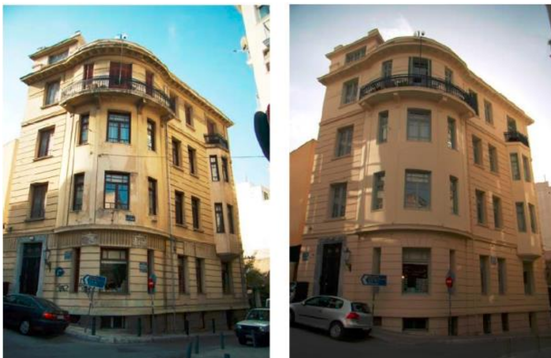
Εικόνα 4-5: Κτίριο στην οδό Βουλής 46 πριν και μετά
