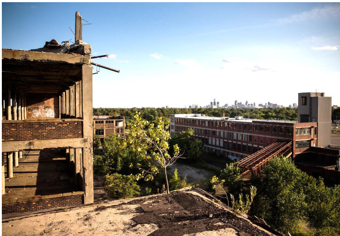
Εικόνα 1-3: Εγκαταλελειμμένες εγκαταστάσεις αυτοβιομηχανίας (Packard Automotive) Πηγή: Detroit ruins and abandoned buildings, huffingtonpost.com
