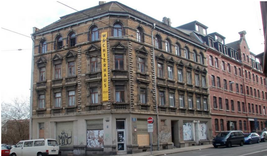
Εικόνα 1-9: Ιστορικό κτίριο προς αξιοποίηση Η χαρακτηριστική επιγραφή “ Wächterhaus ” είναι ο τρόπος αναγνώρισης των κτιρίων που προσφέρονται για αξιοποίηση. Πηγή: HausHalten e.V. Leipzig, haushalten.org
