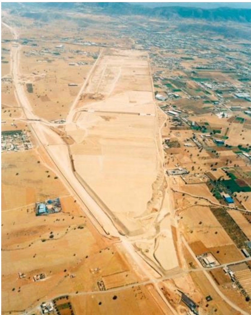
Εικόνα 27: Το Θριάσιο Πεδίο κατά τη περίοδο εκτέλεσης των πρώτων έργων υποδομής Πηγή: gaiaose.com
