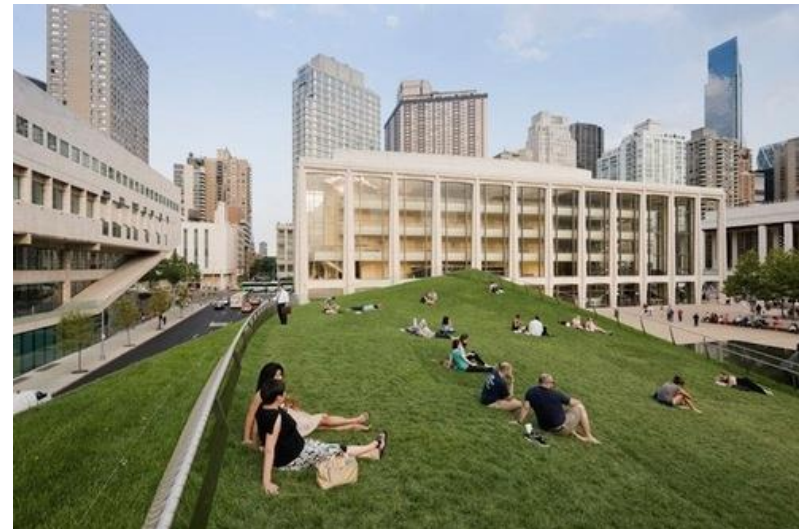
Εικόνα 37: Ανάγλυφοι χώροι πρασίνου, Rooftop park New York Πηγή: gizmodo.com.au
