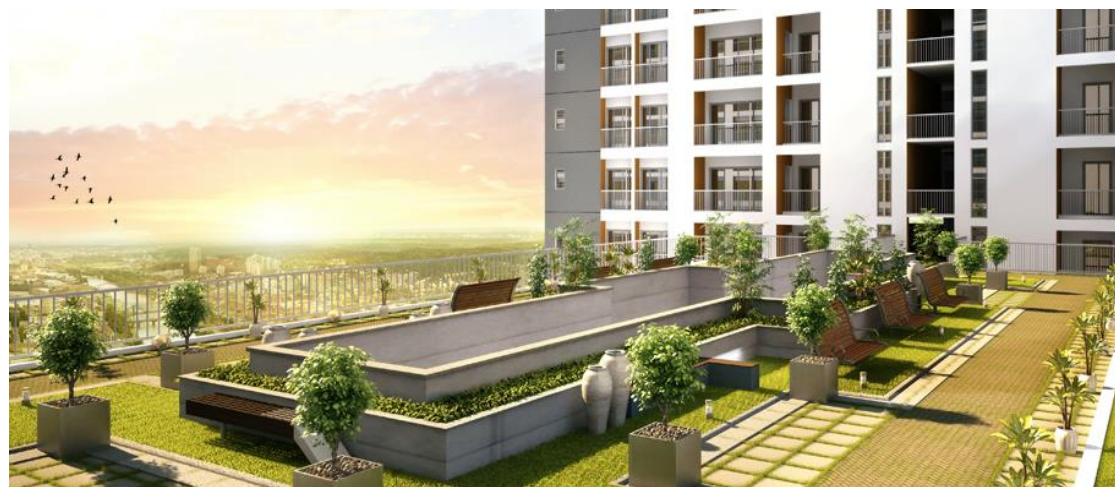
Εικόνα 30: Πράσινες στέγες - αυξημένη μόνωση κτιρίων, περιβαλλοντικά και αισθητικά οφέλη
