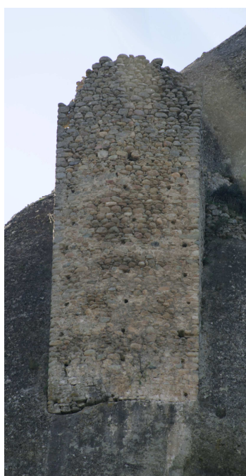
Εικόνες 30-31: Η βόρεια όψη του Πύργου πριν και μετά την αναγωγή. Όπως φαίνεται από τον λόγο των υψών, η γωνία του άξονα λήψης με το επίπεδο της αναγωγής είναι περίπου 40°.
