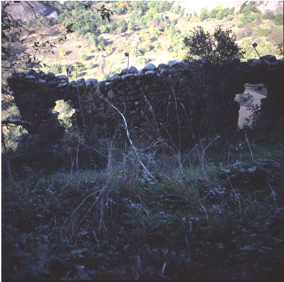
Εικόνα 33: Η νότια όψη του τοίχου όπως φωτογραφήθηκε από πάνω κατά την πρώτη επίσκεψη. Διακρίνονται ορισμένα από τα ειδικά φωτοσταθερά του έχουν τοποθετηθεί.
