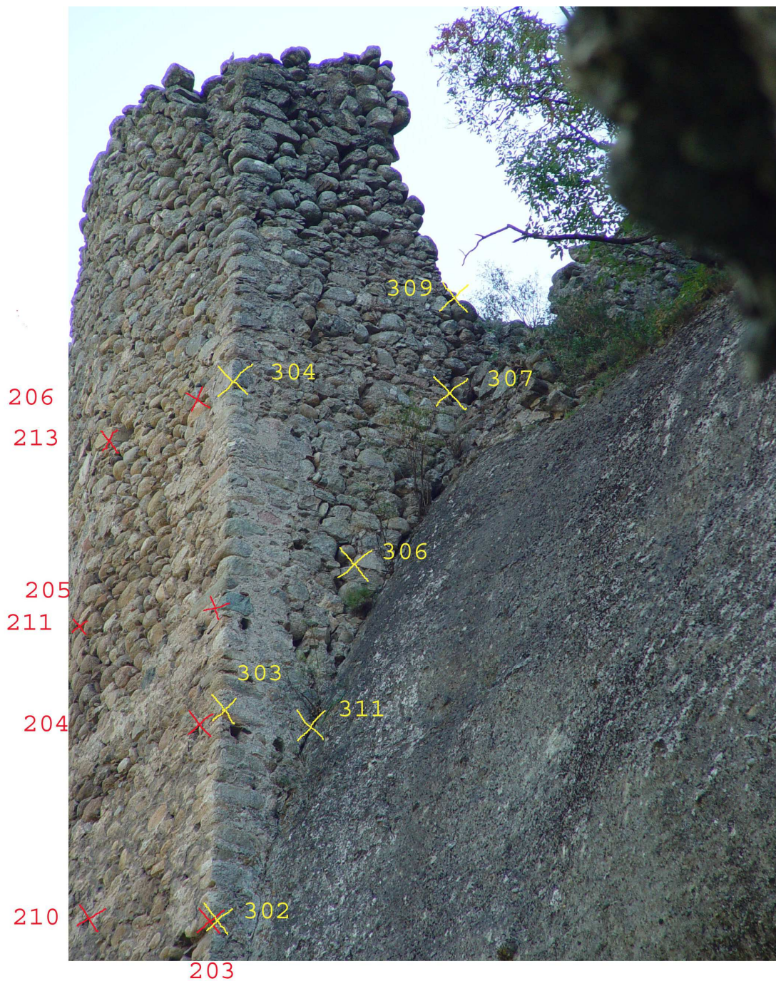
Εικόνα 32: Η δυτική και μέρος της βόρειας όψης του πύργου. Φαίνονται με κόκκινο χρώμα τα φωτοσταθερά που μπόρεσαν να επισημανθούν στη βόρεια όψη, ενώ με κίτρινο χρώμα τα φωτοσταθερά όπως υπολογίστηκαν στη διαδικασία που περιγράφεται στο κείμενο (εδάφιο 5.2).
