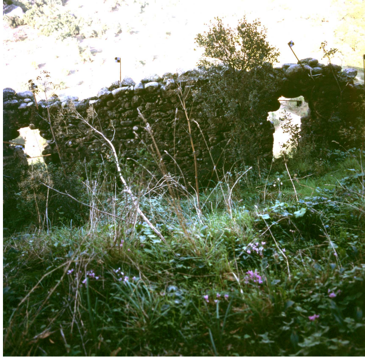
Εικόνα 22: Μία από τις φωτογραφίες που απεικονίζουν την πίσω όψη του τείχους. διακρίνονται ορισμένα από τα ειδικά φωτοσταθερά.
