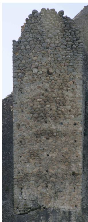
Εικόνες 30-31: Η βόρεια όψη του Πύργου πριν και μετά την αναγωγή. Όπως φαίνεται από τον λόγο των υψών, η γωνία του άξονα λήψης με το επίπεδο της αναγωγής είναι περίπου 40°.
