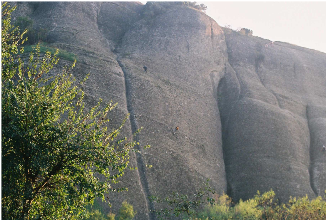
Εικόνα 26: Η κατάβαση μετά το πέρας των εργασιών.
