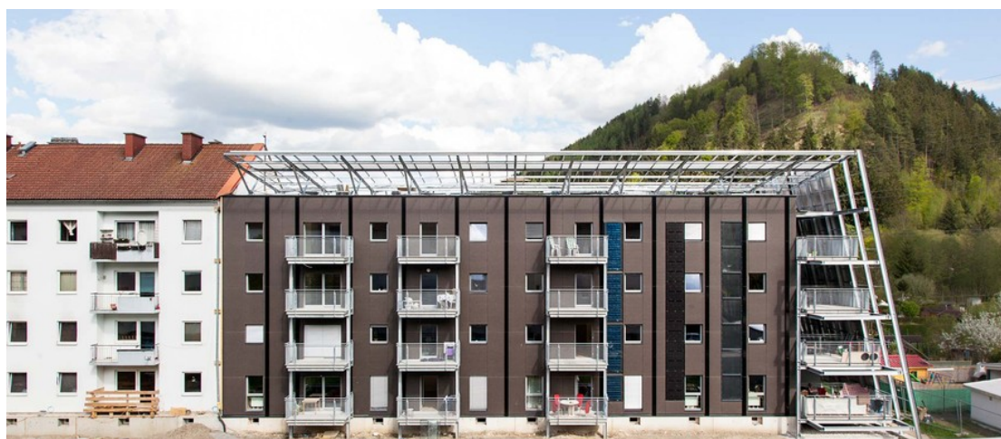
Σχήμα 2.24: Κατασκευή για τοποθέτηση ηλιακών συλλεκτών και φωτοβολταϊκών. [33]
