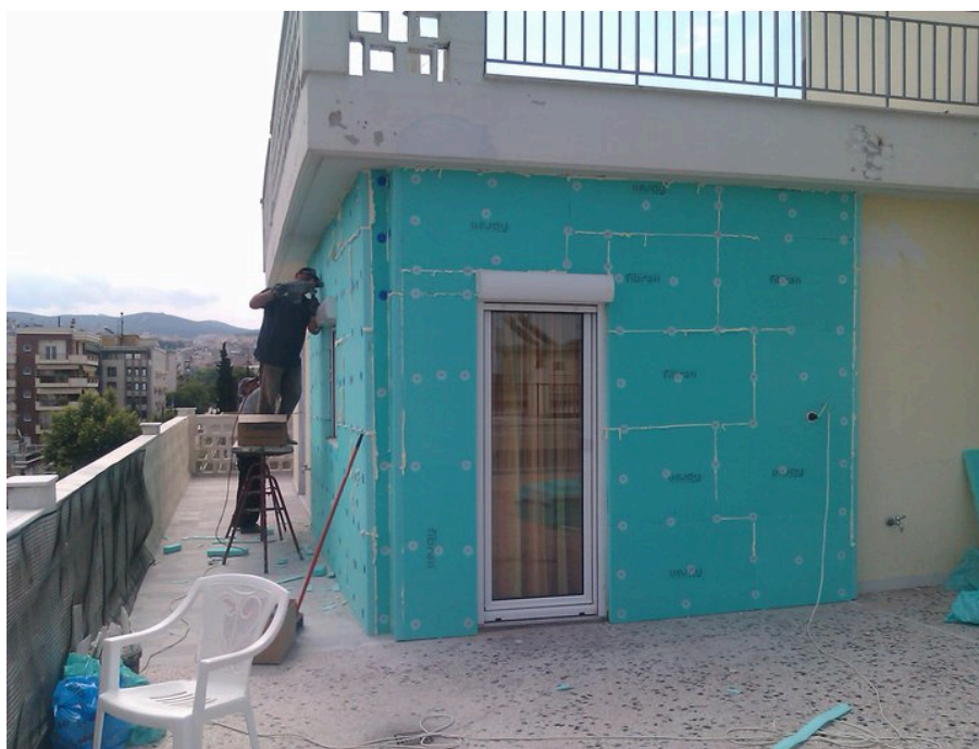
Σχήμα 2.7: Εφαρμογή εξωτερικής θερμομόνωσης κελύφους.
