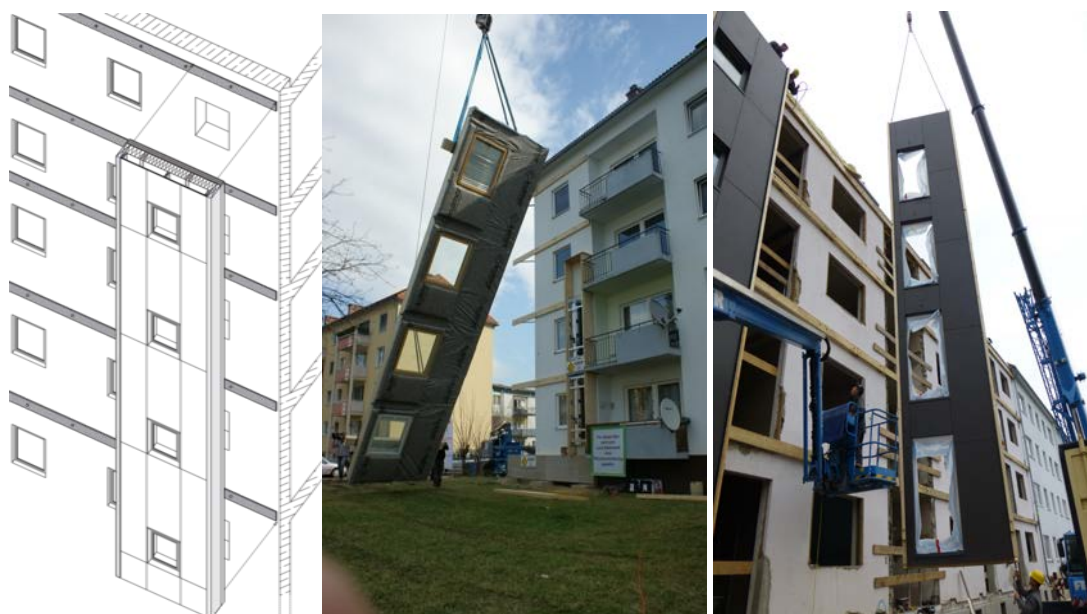
Σχήμα 2.23: Σχεδιασμός και τοποθέτηση προκατασκευασμένων προσόψεων. [34]
