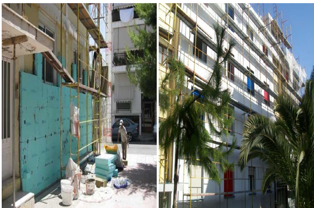
Σχήμα 2.35: Φάση εργασιών (τοποθέτηση εξωτερικής θερμομόνωσης). [40]
