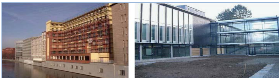
Σχήμα 4.2.1.6.1.4: Κτίρια γραφείων στα οποία έχουν ενσωματωθεί γυψοσανίδες PCM, [20]
