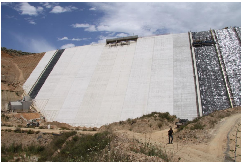
Εικόνα 5.21 Ανάντη πλάκα στεγάνωσης φράγματος Βαλσαμιώτη
