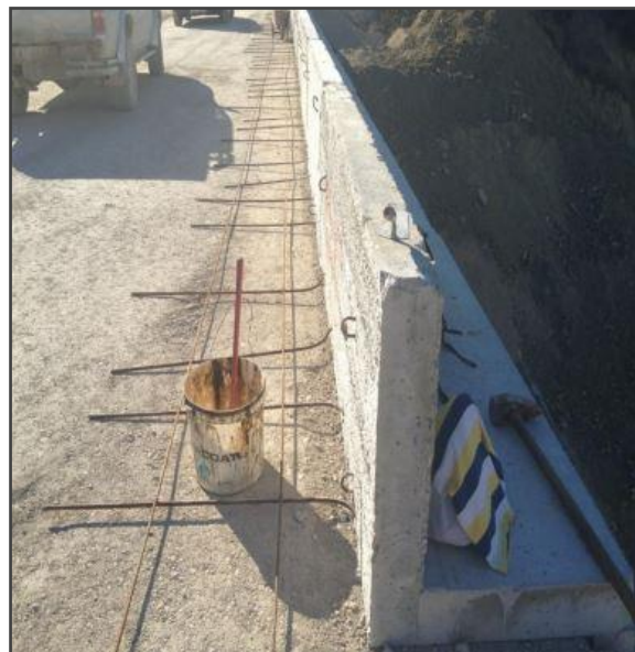
Εικόνα 5.26 Προκατασκευασμένα στοιχεία διατομής L (Φιλιατρινό)
