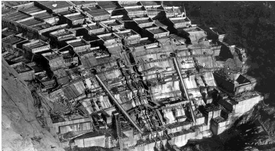
Εικόνα 2.5 Άποψη φράγματος Hoover, όπου φαίνονται οι ξυλότυποι των μονολιθικών μπλοκ.
