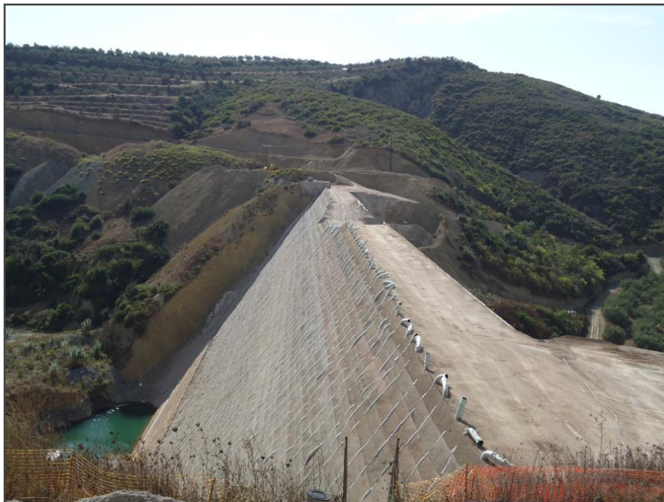
Εικόνα 5.28 Κατάντη πρηνές φράγματος & αποστραγγιστικοί σωλήνες (Φιλιατρινό)
