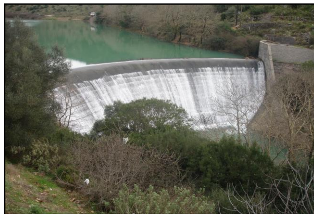
Εικόνα 1.4Αποψη φράγματος Λούρου την ώρα της υπερχειλίσης
