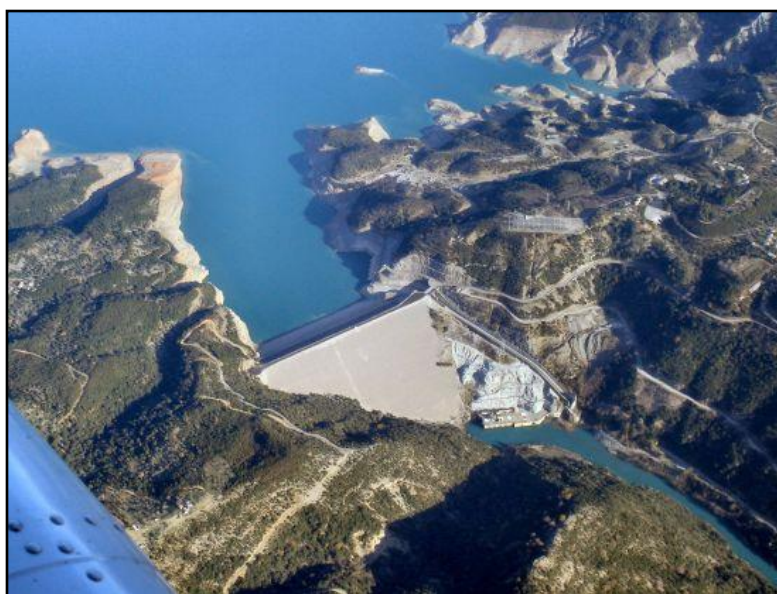
Εικόνα 1.7 Εναέρια άποψη του φράγματος Κρεμαστών και του ταμιευτήρα.
