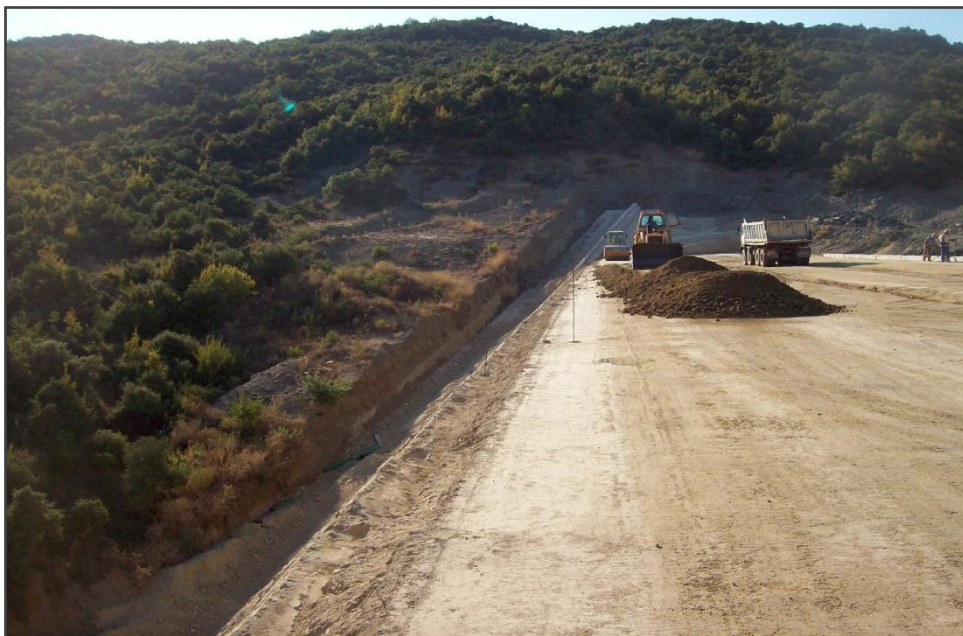
Εικόνα 5.37 Διάστρωση Σ.Ε. φράγματος Ληθαίου
