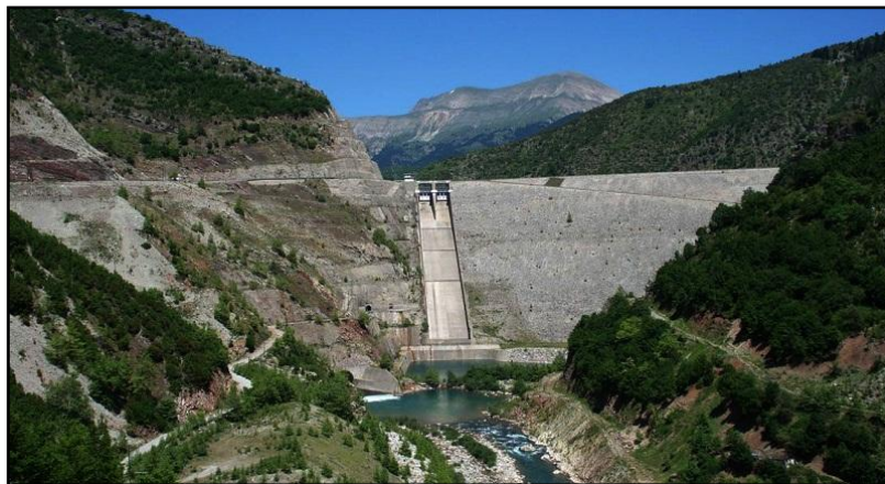
Εικόνα 1.8 Κατάντη όψη φράγματος Μεσοχώρας (υπερχειλιστής στο δεξι αντέρεισμα)
