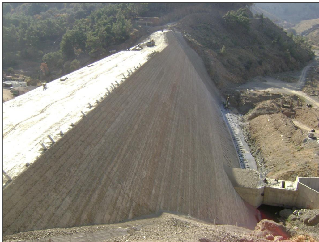
Εικόνα 5.9 Ανάντη όψη φράγματος Κόρη-Γεφύρι
