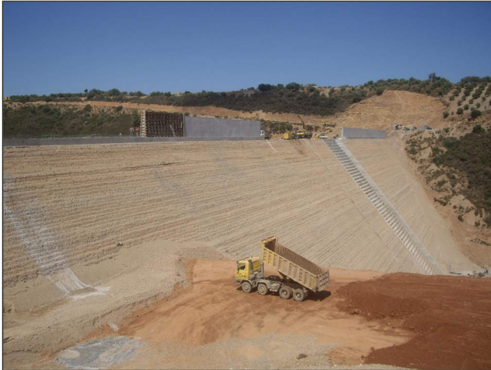
Εικόνα 5.16 Κατάντη όψη φράγματος Βαλσαμιώτη λίγο πριν την ολοκλήρωση
