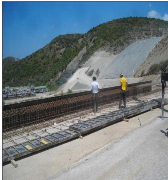
Εικόνα 5.27 Μεταλλότυπος & σκυροδέτηση υπερχειλιστή (Φιλιατρινό)
