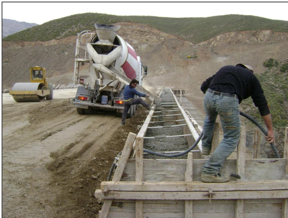
Εικόνα 5.13 Ξυλότυπος & σκυροδέτηση υπερχειλιστή
