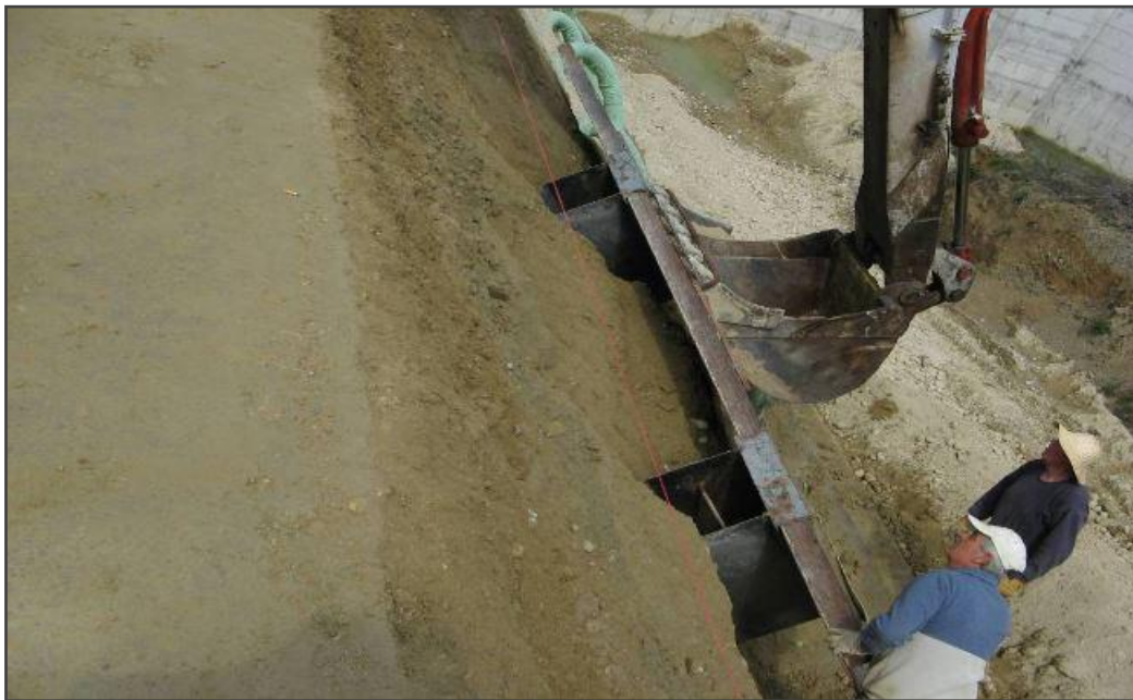
Εικόνα 5.35 Μεταλλότυπος διαμόρφωσης ανάντη παρειάς Ληθαίου.
