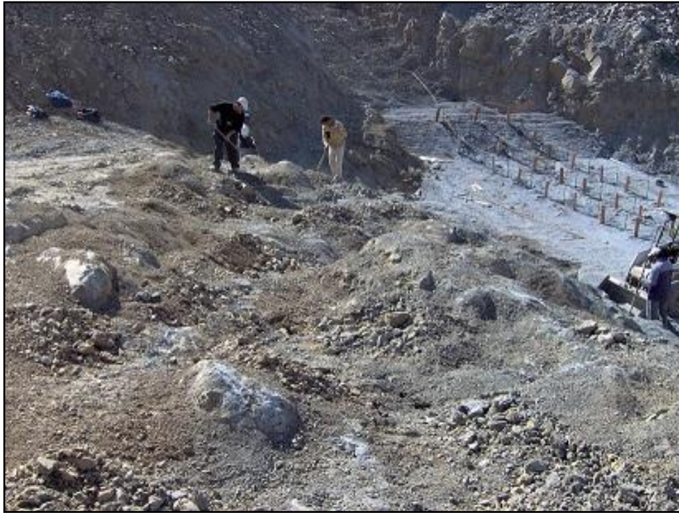
Εικόνα 3.6 Καθαρισμός εδάφους θεμελίωσης
