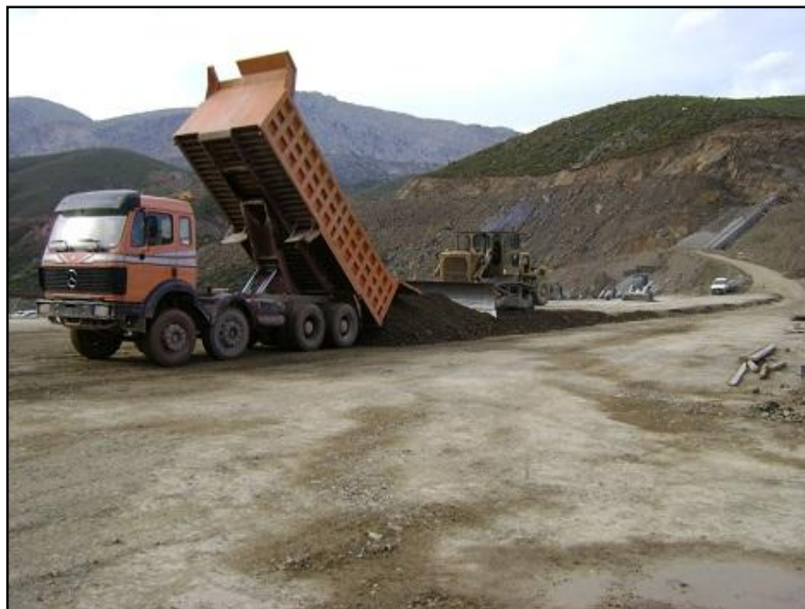
Εικόνα 3.7 Διάστρωση μείγματος
