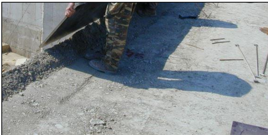
Εικόνα 3.9 Τελική επιφάνεια στρώσης σκληρού επιχώματος
