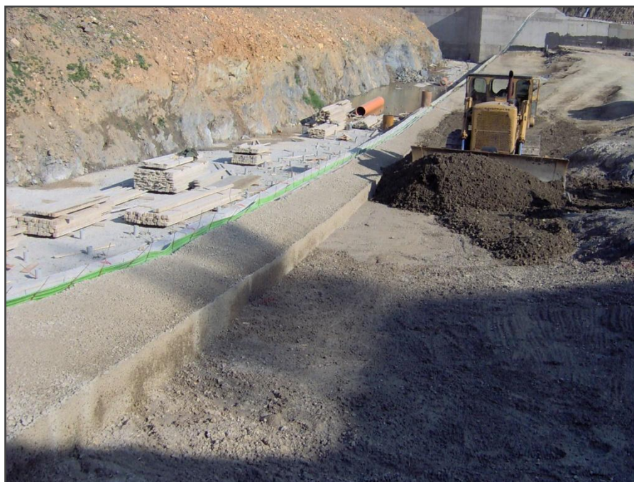
Εικόνα 5.11 Σκυρόδεμα εξομάλυνσης θεμελίωσης Κόρη-Γεφύρι
