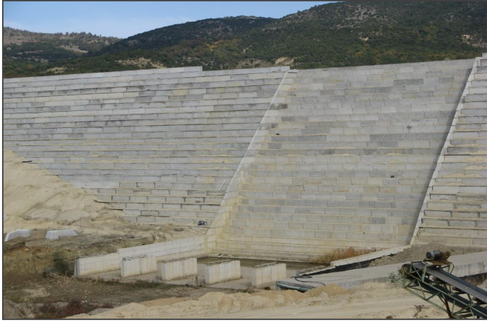
Εικόνα 5.36 Κατάντη πρανές & υπερχειλιστής (Ληθαίο)
