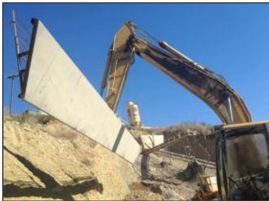
Εικόνα 5.25 Μεταλλότυπος διαμόρφωσης ανάντη πρανούς (Φιλιατρινό)
