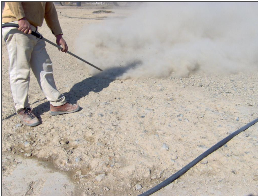
Εικόνα 5.10 Καθαρισμός θεμελίωσης Κόρη-Γεφύρι
