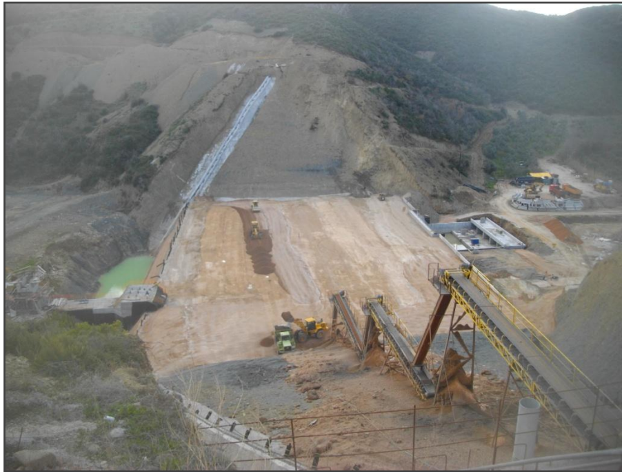
Εικόνα 5.29 Μεταφορικές ταινίες υλικού Σ.Ε. (Φιλιατρινό)
