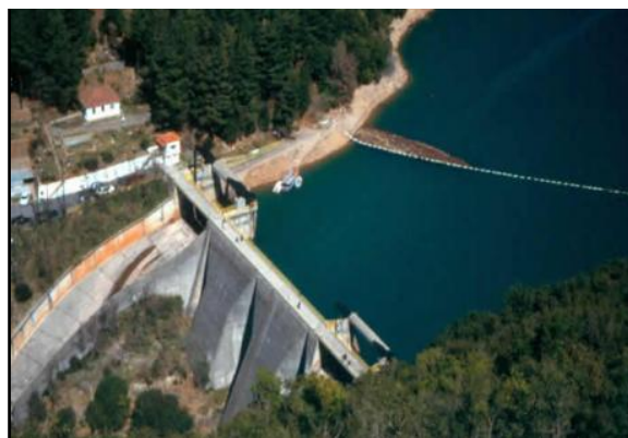
Εικόνα 1.6 Αλοψη του φράγματος με τις χαρακτηριστικές αντηρίδες και η λίμνη
