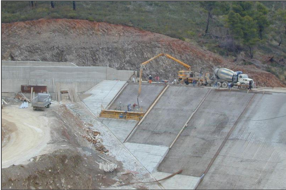
Εικόνα 3.2 Σκυροδέτηση τριγωνικών φατνωμάτων βάσης ανάντη πλάκας
