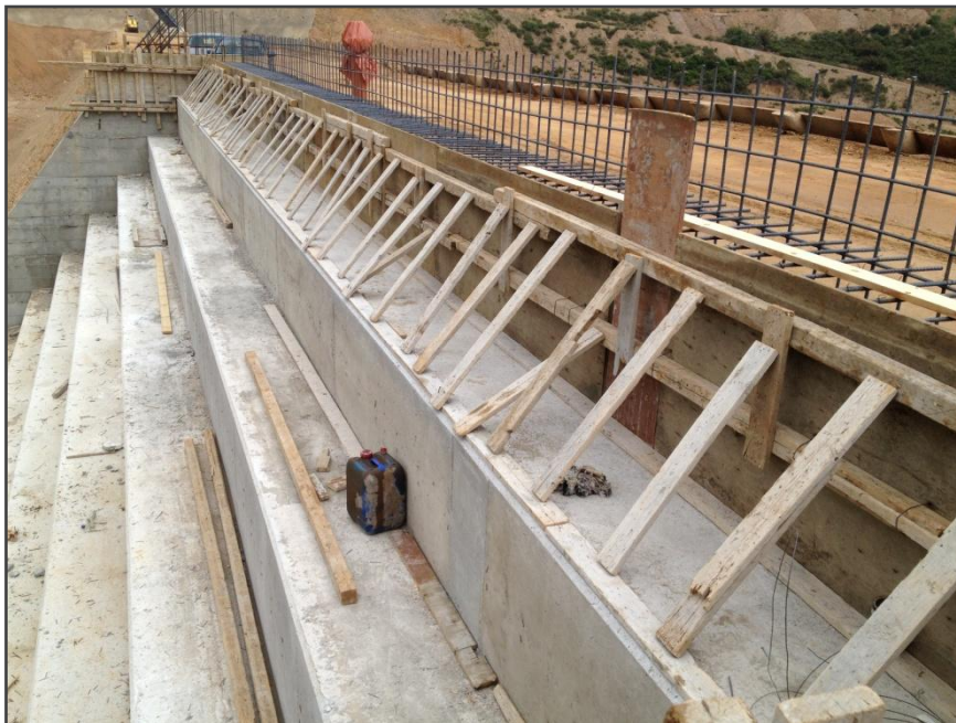
Εικόνα 5.20 Εσλότοπος Υπερχειλιστή φράγμα Βαλσαμιώτη
