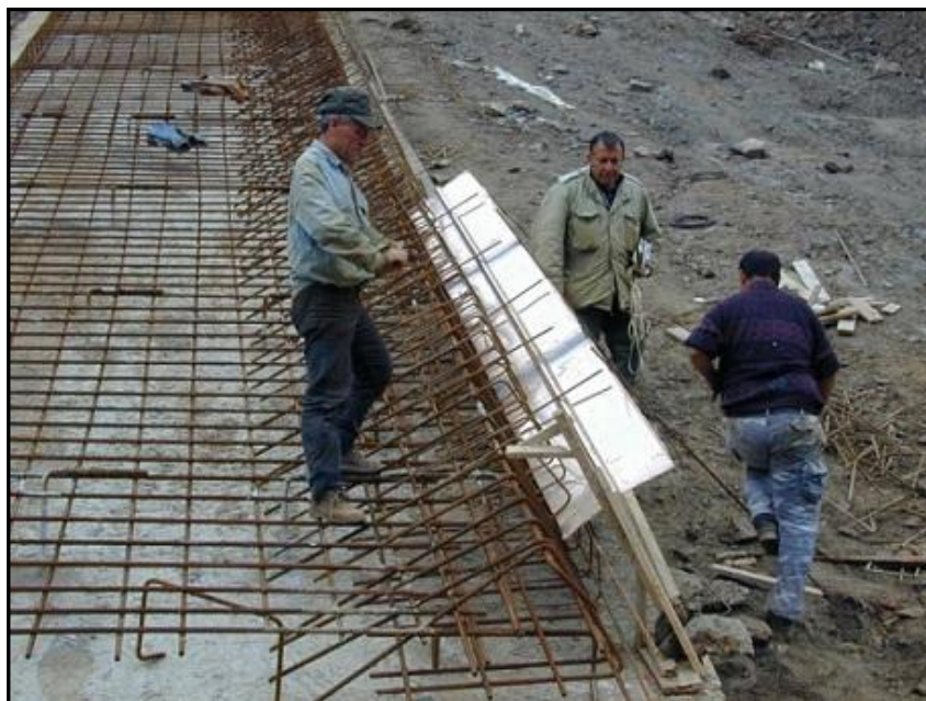
Εικόνα 3.3 Διάταξη και τάξη μεγέθους οπλισμών πλίνθου.
