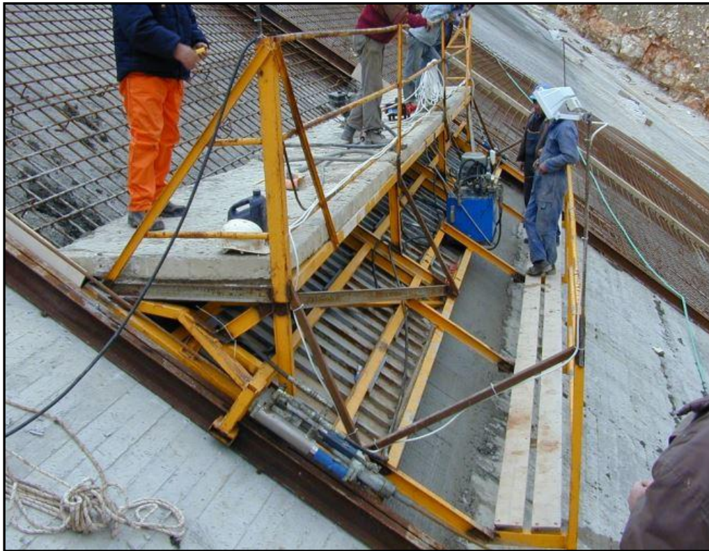
Εικόνα 3.3 Απεικόνιση τοπικής μορφής κλιόμενου μεταλλότυπου.
