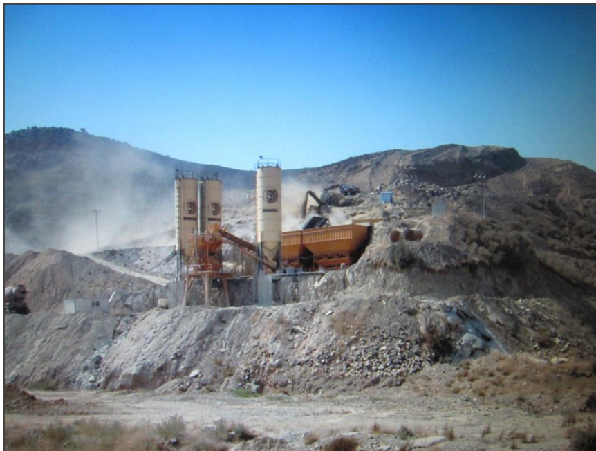
Εικόνα 5.15 Συγκρότημα παραγωγής αδρανών Κόρη-Γεφύρι
