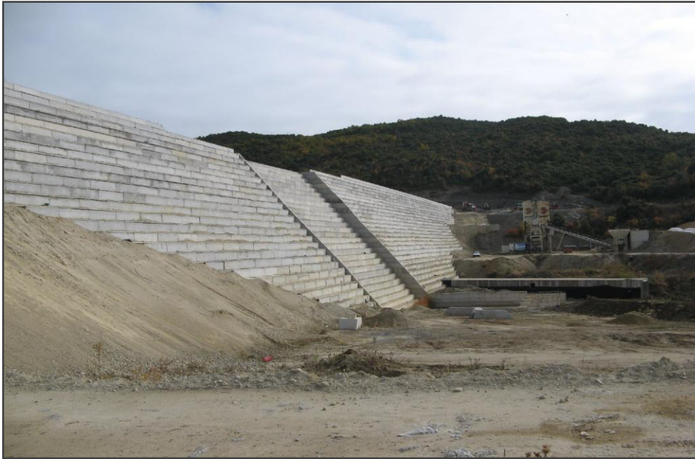
Εικόνα 5.32 Κατάλητη όψη φράγματος Ληθαιού
