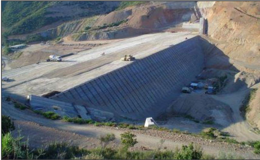
Εικόνα 5.18 Διάστρωση Σ.Ε. φράγμα Βαλαμιώτη.
