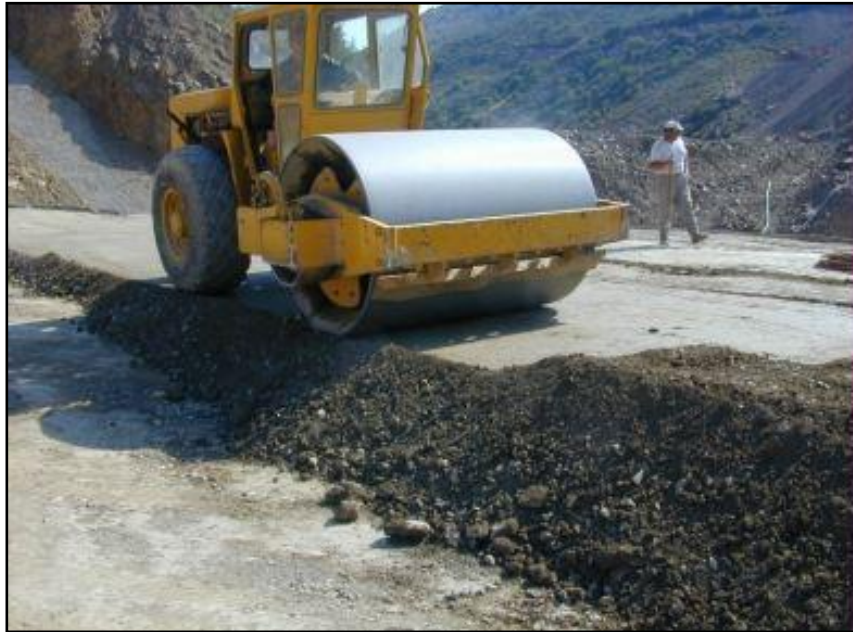
Εικόνα 3.8 Συμπύκνωση υλικού
