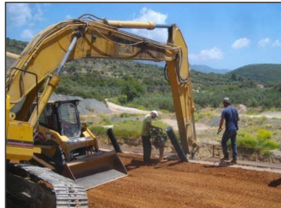
Εικόνα 5.25 Μεταλλότυπος διαμόρφωσης ανάντη πρανούς (Φιλιατρινό)
