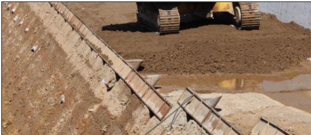
Εικόνα 5.19 Μεταλλότυποι μόρφωσης πρηνών φράγματος Βαλαμιώτη.
