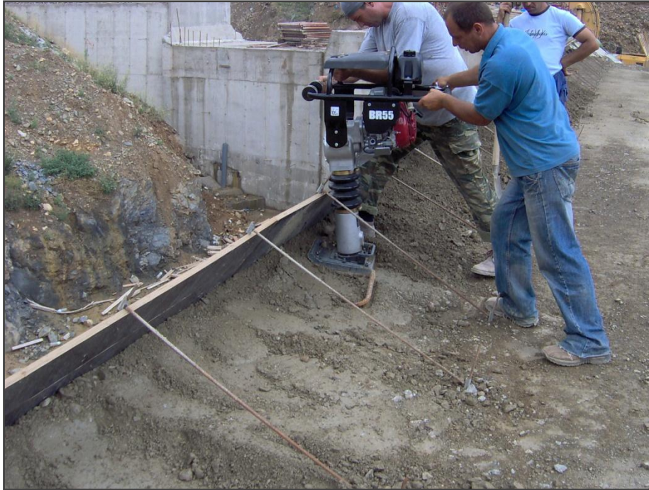
Εικόνα 5.12 Ξυλότυπος πρανών και τοπική συμπίκνωση υλικού
