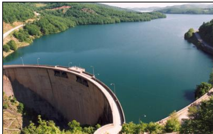
Εικόνα1.1 Άποψη φράγματος Ταυρωπού και του ταμιευτήρα
