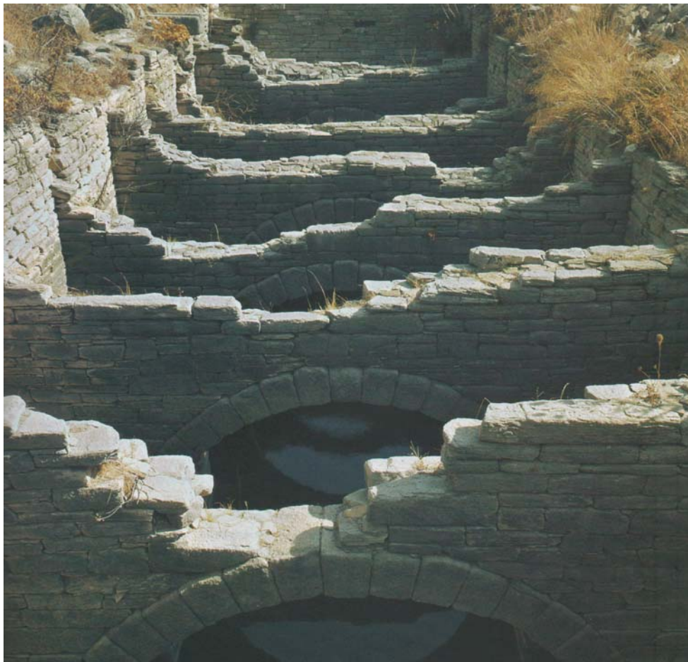
Εικ. 4.11. Αψίδες στη δεξαμενή του θεάτρου στη Δήλο. – 2 ος αιώνας π.Χ.
