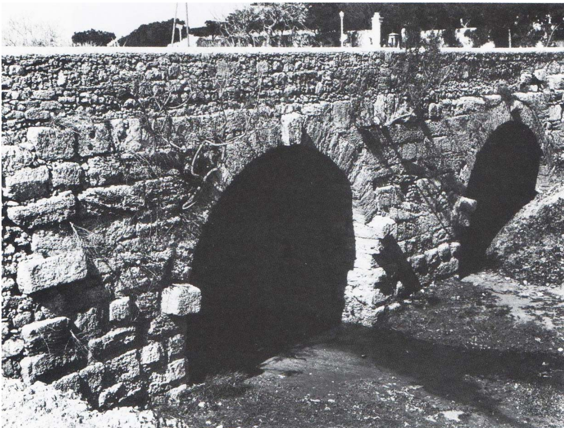
Εικ. 5.14. Η γέφυρα του ποταμού Ροδινιού.
