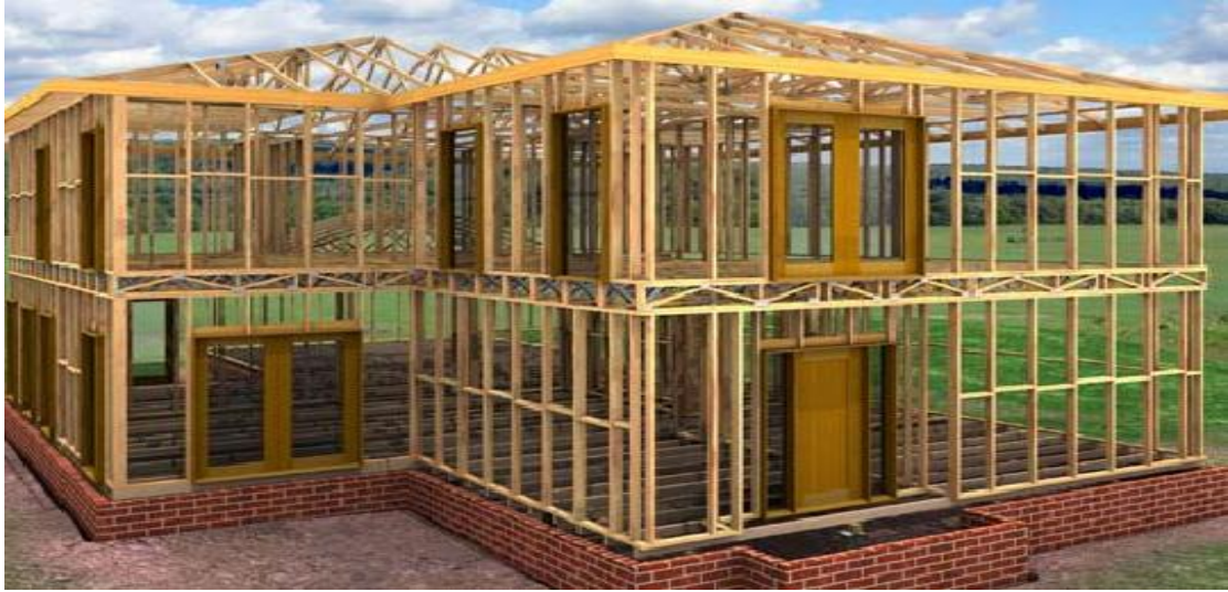
Εικόνα 2.1 Καφασωτός σκελετός πριν την στερέωση των δομικών φύλλων. ( www.allwood.gr )
