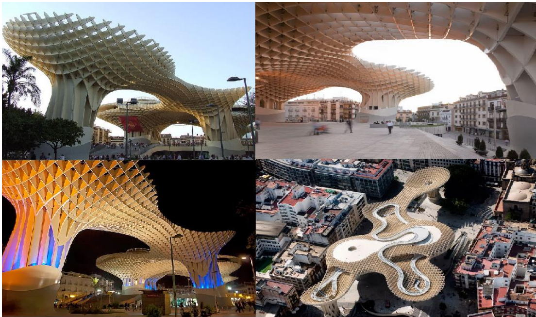
Εικόνα 1.1 Η μεγαλύτερη ξύλινη κατασκευή στον κόσμο βρίσκεται στην Ισπανία ( http://traveltipsgr.blogspot.com )
