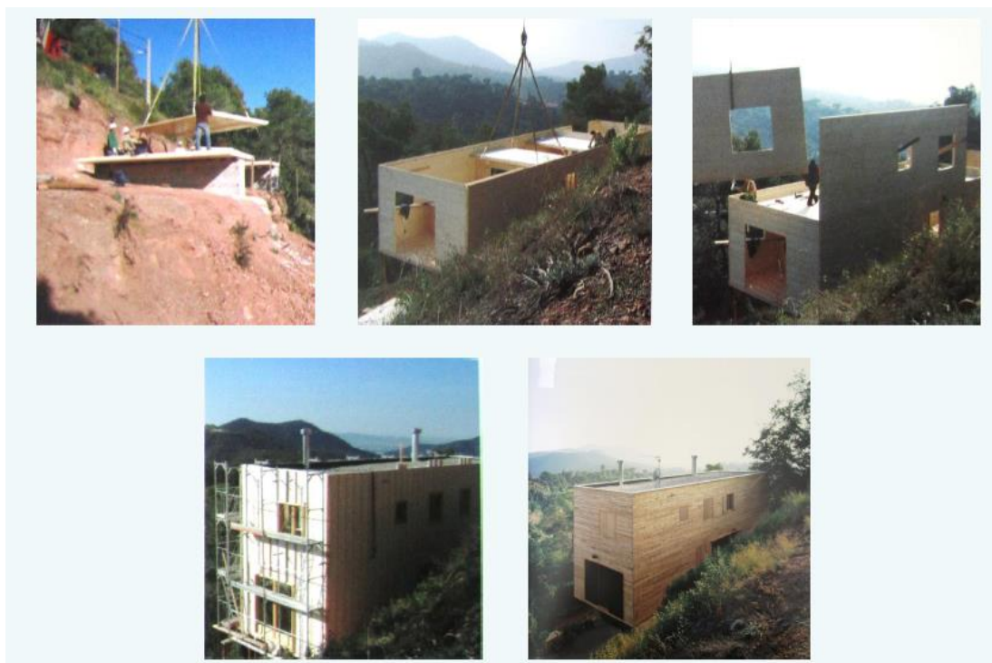
Εικόνα 2.18 Κατασκευή κτιρίου τύπου πάνελ. ( http://www.easyhomeprokat.gr/ )
