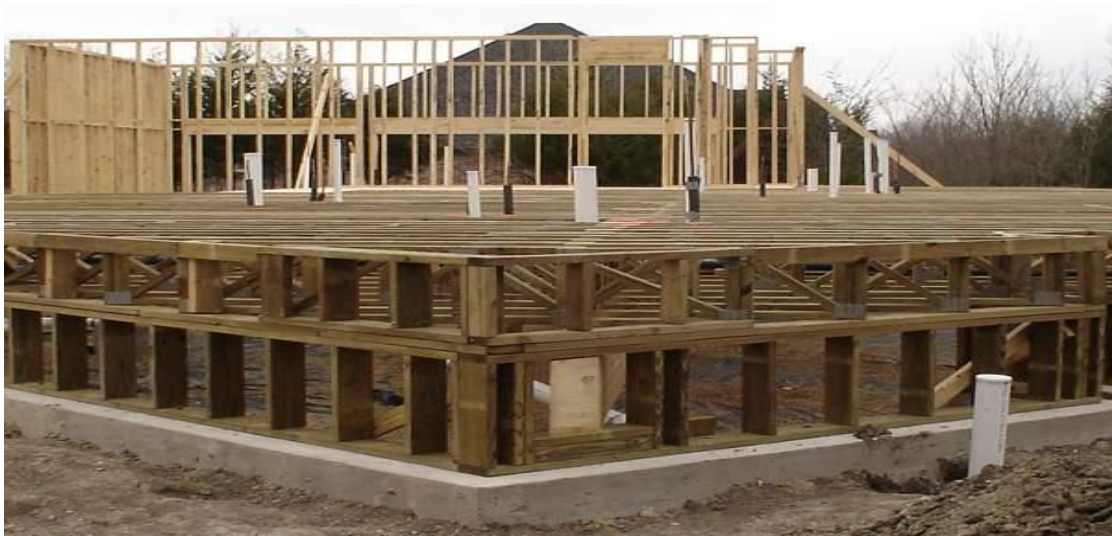
Εικόνα 2.2 Φάση κατασκευής πλατφόρμας χωρίς υπόγειο. ( www.allwood.gr )
