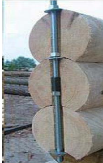
Εικόνα 2.9 Σύνδεση με ανοξειδωτες μεταλλικές ράβδους.
