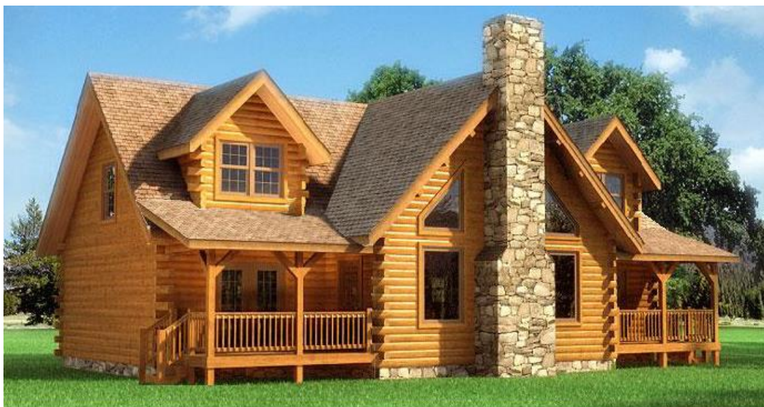
Εικόνα 2.4 Κατοικία με οριζόντια τοποθέτηση κορμών. ( http://www.xilokatoikia.gr )
