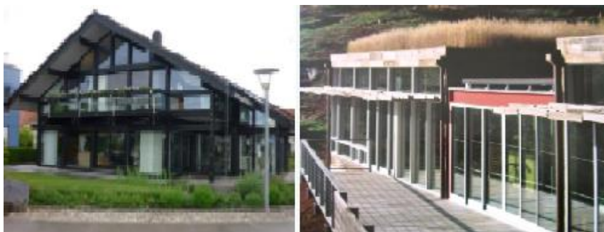
Εικόνα 2.11 Κατασκευές τύπου δοκού επί στύλου. ( http://www.easyhomeprokat.gr/ )
