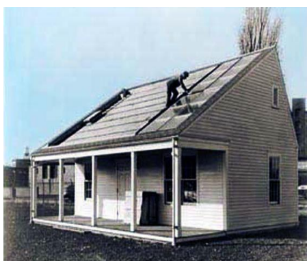
εικόνα 1:2 Το 'Solar House I' (3)
