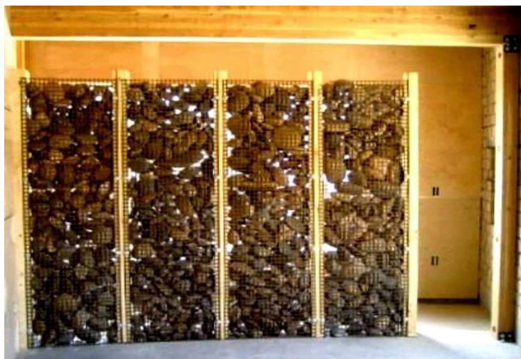
εικόνα 4:2 τοίχος μάζας κατά την κατασκευή με χρήση πέτρας
