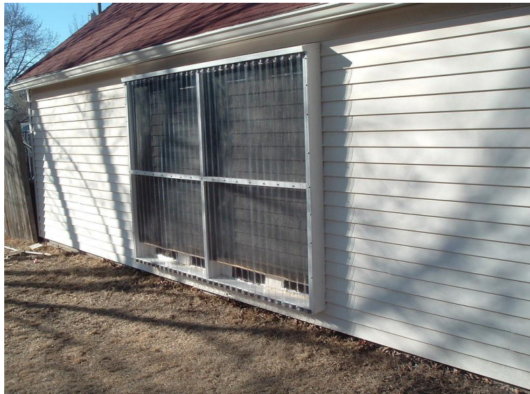
εικόνα 4:10 τοίχος σε κατοικία με φωτοβολταϊκά (55)
