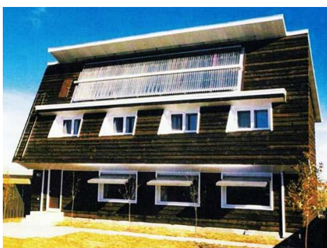
εικόνα 1:4 το κτίριο 'Saskatchewan Conservation House' στις Ηνωμένες Πολιτείες το 1979 (4)
