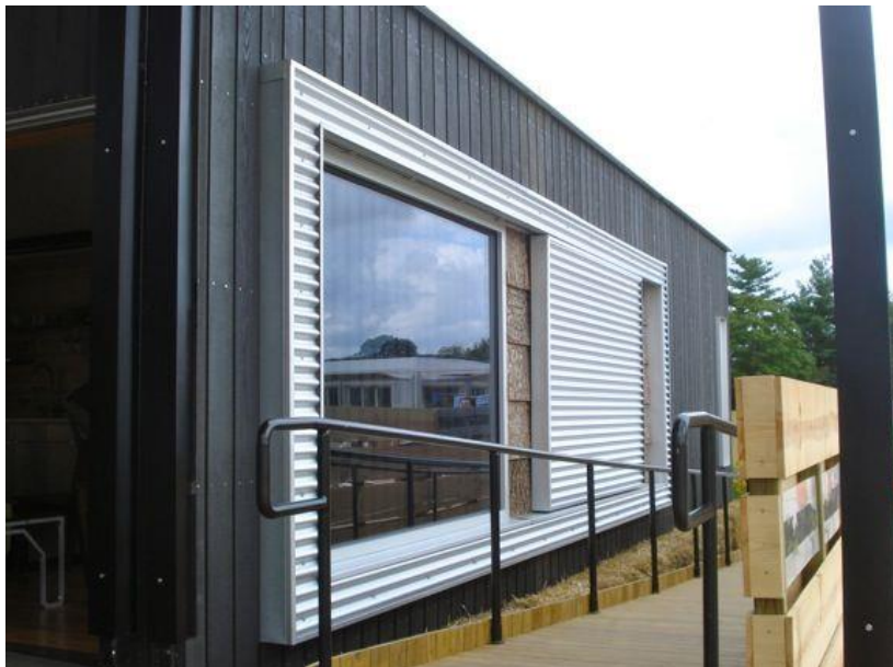
εικόνα 4:8 τροποποιημένος τοίχος μάζας σε κατοικία (56)
