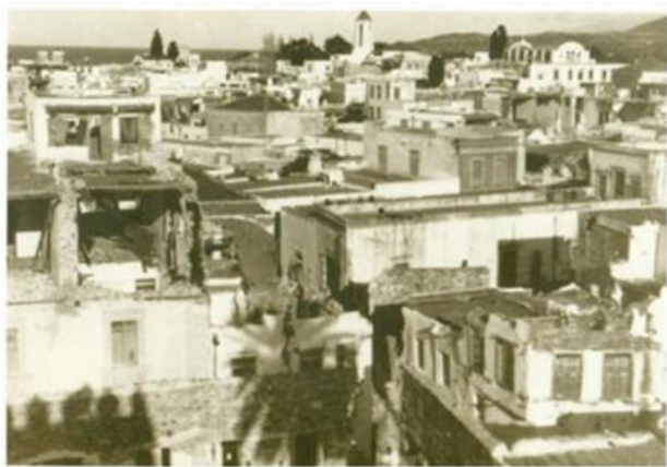
Εικόνα 9- 6 Άποψη της κατεστραμμένης πόλης από το σεισμό του 1933 [6]
