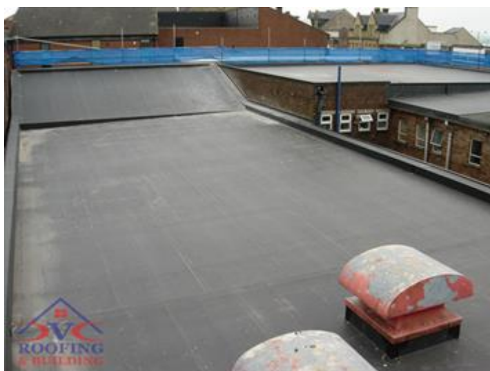
Εικόνα 2.1: Μονωτική επίστρωση στέγης με EPM
