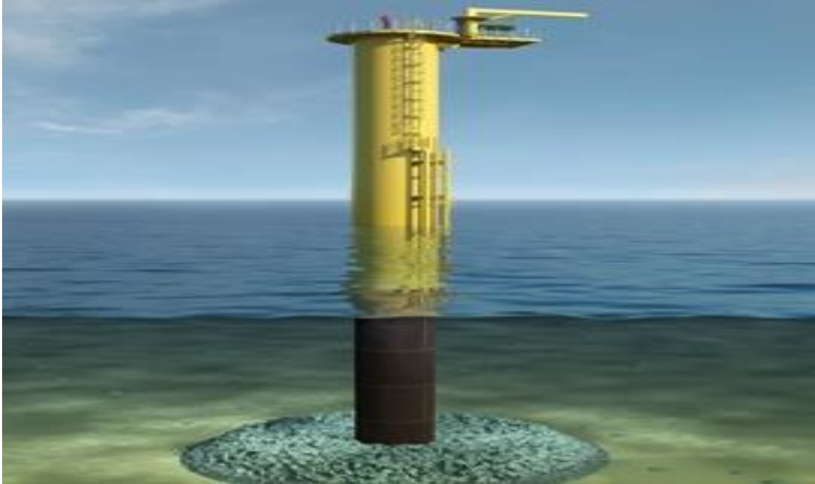
Σχήμα 35: Θεμελίωση με έμπηξη μονού πυλώνα
