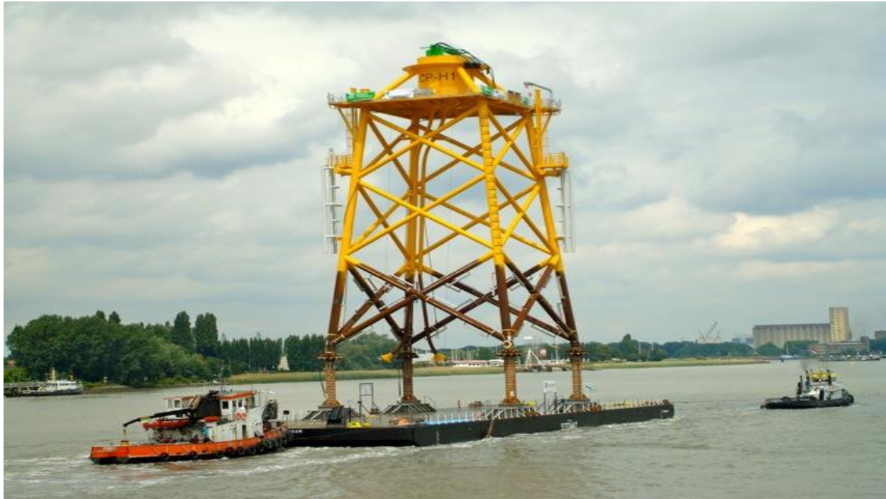
Σχήμα 49: Μεταλλικό τετράποδο δικτύωμα (Jacket)
