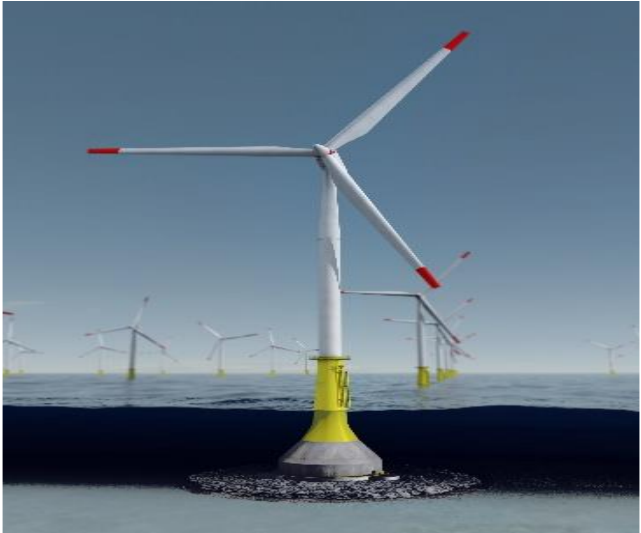
Σχήμα 23: Επιφανειακή θεμελίωση βαρύτητας
