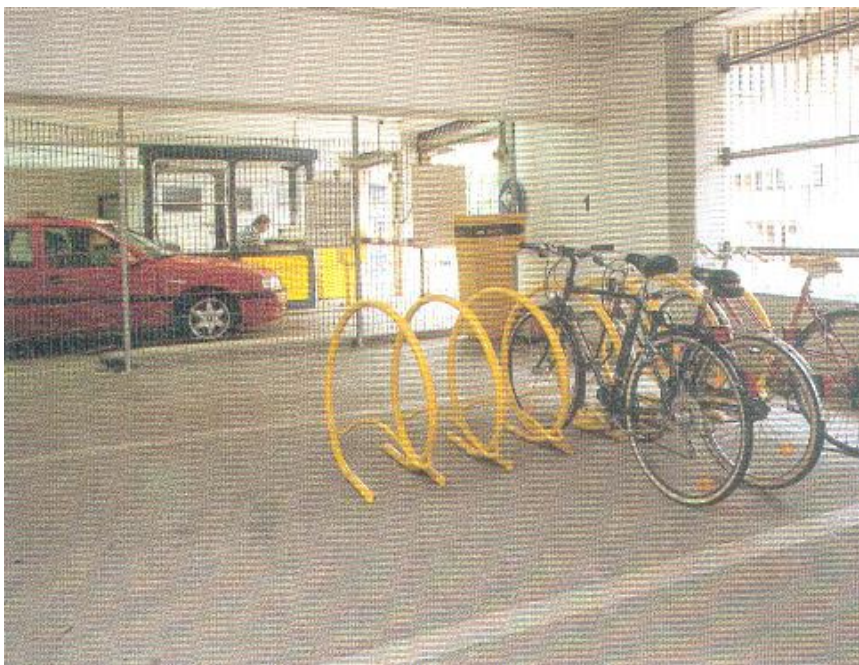
Διατάξεις μεταλλικών συστημάτων υποστήριξης του τροχού
