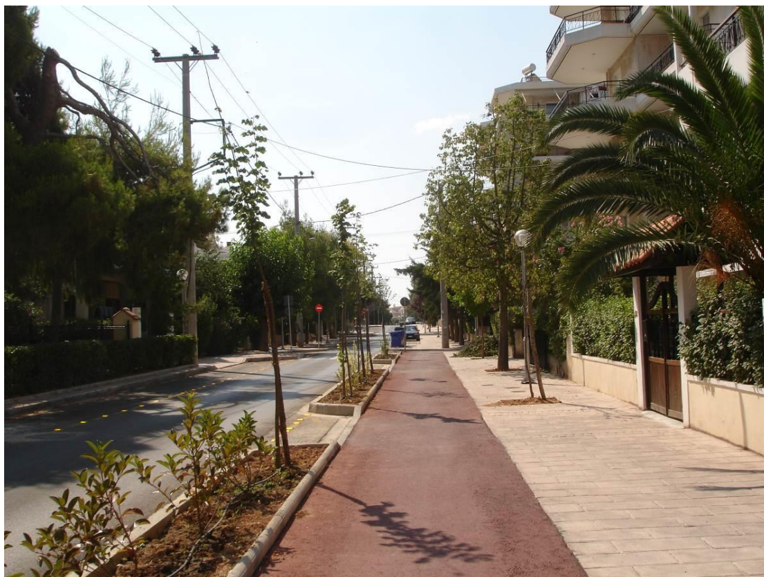
Ανάπλαση οδού ΜΠΑΚΟΓΙΑΝΝΗ στον Δήμο Βριλησίων σε πεζόδρομο – ποδηλατόδρομο (2006)
