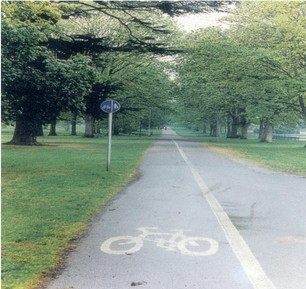
Ανεξάρτητος διάδρομος με διαχωρισμό της επιφάνειας κίνησης των ποδηλάτων και των πεζών
