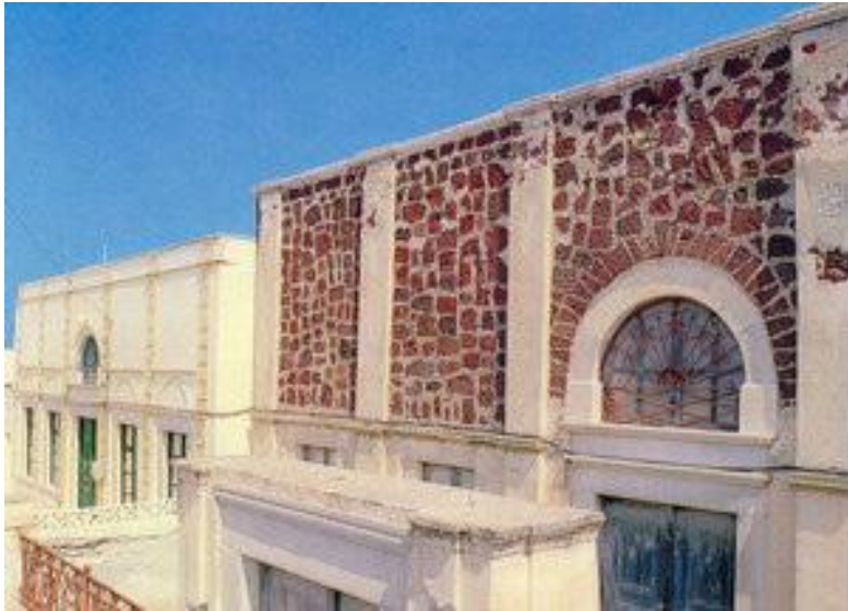
Εικ. 1.3: Δύο καπετανόσπιτα πάνω στον κεντρικό δρόμο του οικισμού της Οίας. Χρήση συμπαγούς κοκκινόπετρας στην επένδυση τμήματος της όψης [23]
