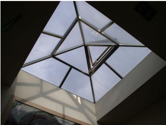
Εικ.6.4: Πυραμιδοειδής κάλυψη σε αίθριο κατοικίας [66]
