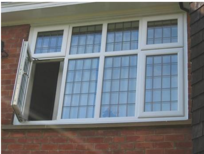
Εικ.6.9: Κατασκευή με ειδικούς υαλοπίνακες [90]
