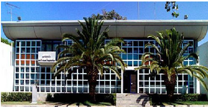
Εικ. 4.4: Δημαρχείο Βουλιαγμένης με σταθερά σκίαστρα από μπετόν [54]
