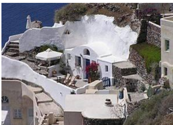
Εικ. 4.14: Εξωτερική όψη υπόσκαφης κατοικίας- Σαντορίνη [46]
