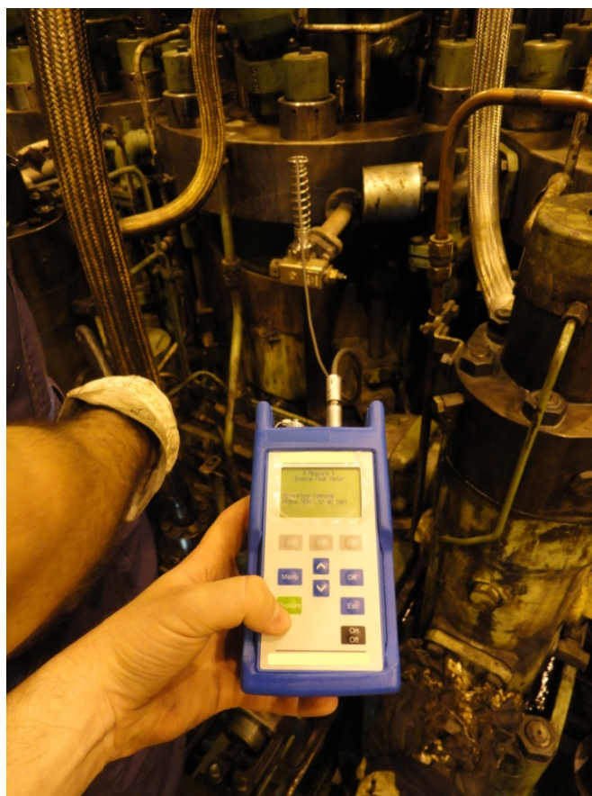
Σχήμα 7.5. Πραγματοποίηση μέτρησης με τη φορητή συσκευή καταγραφής πίεσης καύσης
