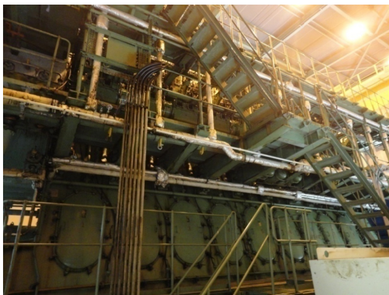
Σχήμα 7.2. Το κλιμακοστάσιο του κινητήρα. Διακρίνονται τα τρία επίπεδα που διαθέτει
