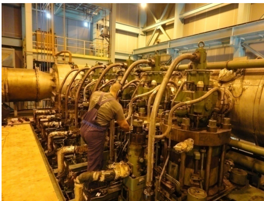
Σχήμα 7.4. Λήψη μετρήσεων πίεσης. Προσαρμογή του πιεζοηλεκτρικού αισθητήρα στο δυναμοδεικτικό κρουνό του κυλίνδρου
