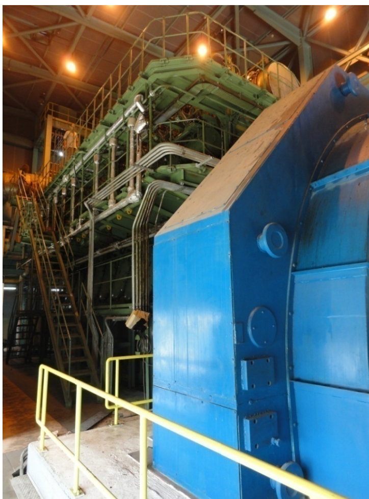
Σχήμα 7.1. Ο κινητήρας 9K60MC-S της MAN B&W στη μονάδα Νο.3 του ΑΣΠ Χίου
