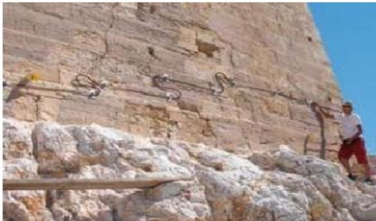
Σχήμα 1-2: Παρακολούθηση της δομικής κατάστασης τεχνικού έργου με τη χρήση αισθητήρων οπτικών ινών Figure 1-2: Structural health monitoring of engineering work with the use of fiber-optics sensors (Πηγή: Εισαγωγή στην οπτοηλεκτρονική-αισθητήρες οπτικών ινών, Τμήμα Φυσικής, Πανεπιστήμιο Κρήτης)
