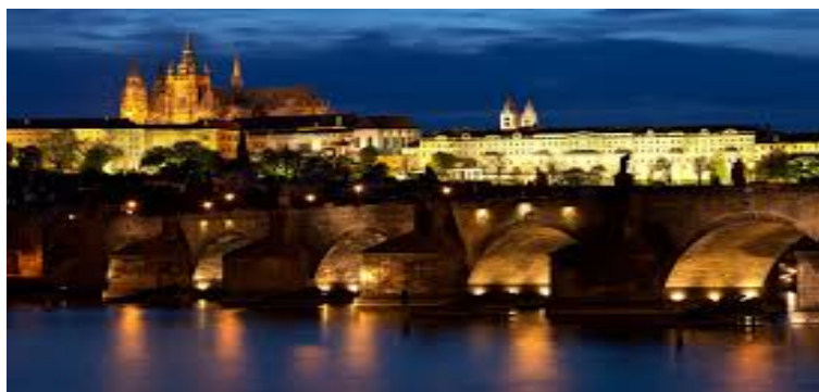
Σχήμα 2-2: Γέφυρα του Καρόλου, Πράγα Figure 2-2: Charles bridge, Prague (Πηγή: http://www.northwestladybug.com/ )
