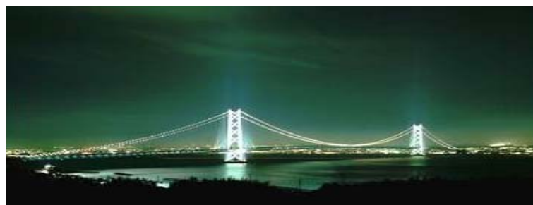
Σχήμα 2-4: Γέφυρα Akashi Kaikyo , Ιαπωνία Figure 2-4: Akashi Kaikyo bridge, Japan (Πηγή: http://wallcapturehd.com/ )
