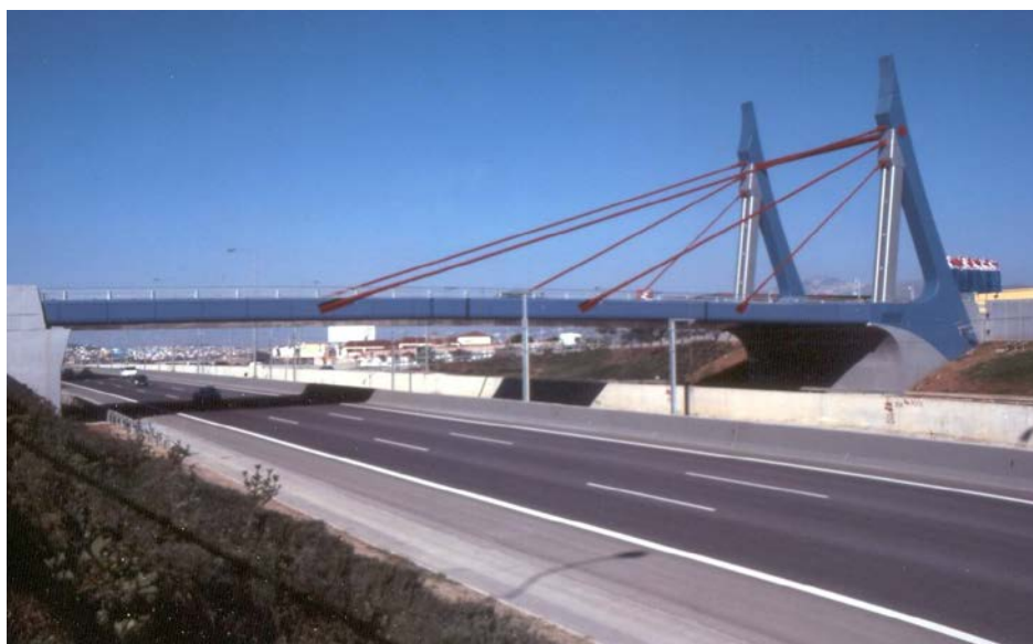
Σχήμα 5-1: Καλωδιωτή γέφυρα ΣΕΑ Μεσογείων, Παλλήνη Figure 5-1: Cable bridge at SEA Mesogeion, Pallini
