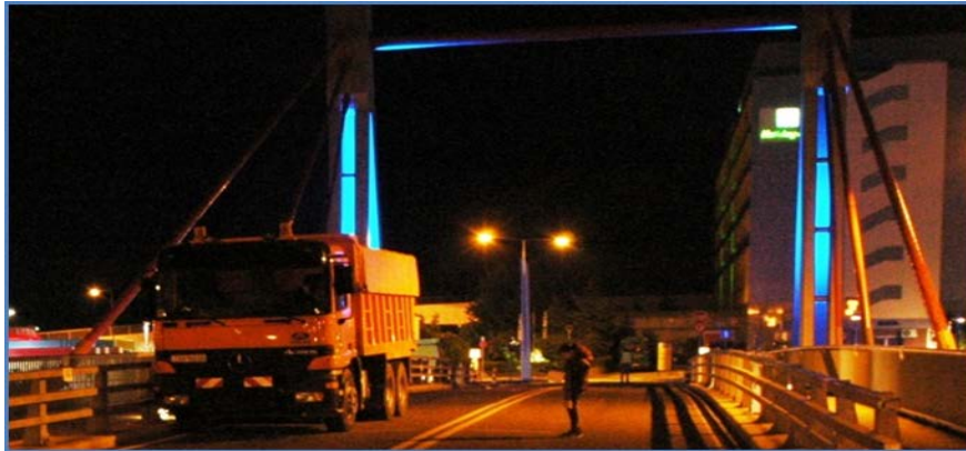
Σχήμα 6-4: Φορτηγό όχημα για τη στατική καταπόνηση της γέφυρας Figure 6-4: Truck for the static load test of the bridge
