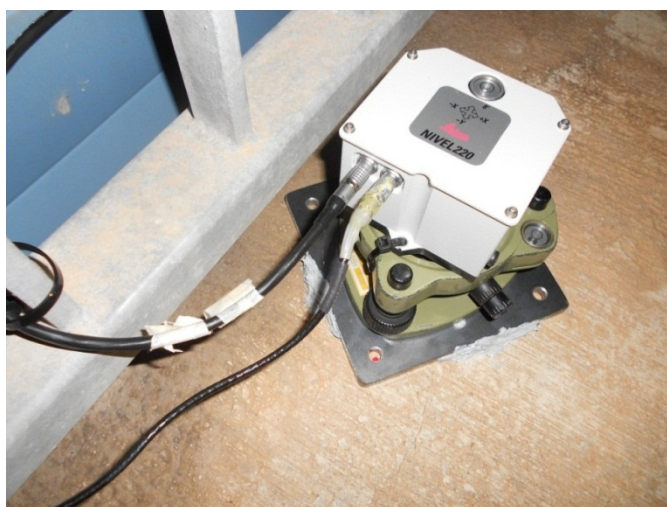
Σχήμα 6-6: Εγκατάσταση συστήματος κλισίμετρου στη γέφυρα Figure 6-6: Installation of inclinometer system in the bridge
