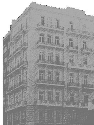
Επταώροφη οικοδομή στην πλατεία Συντάγματος_ Α. Μεταξας_ Ένα από τα πρώτα κτίρια που γίνεται χρήση οπλισμένου σκυροδέματος
