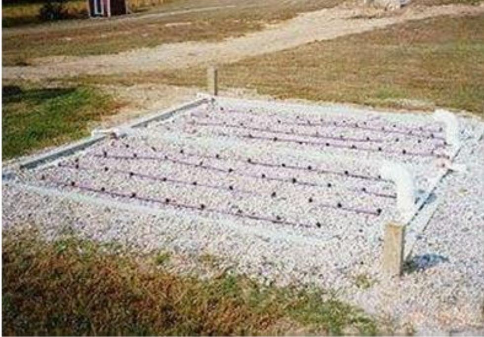
Εικόνα 18: Επιφάνεια φίλτρου άμμου σε σύστημα RSF, Πηγή: ΥΠΕΚΑ Έκδοση Απρίλιος 2012
