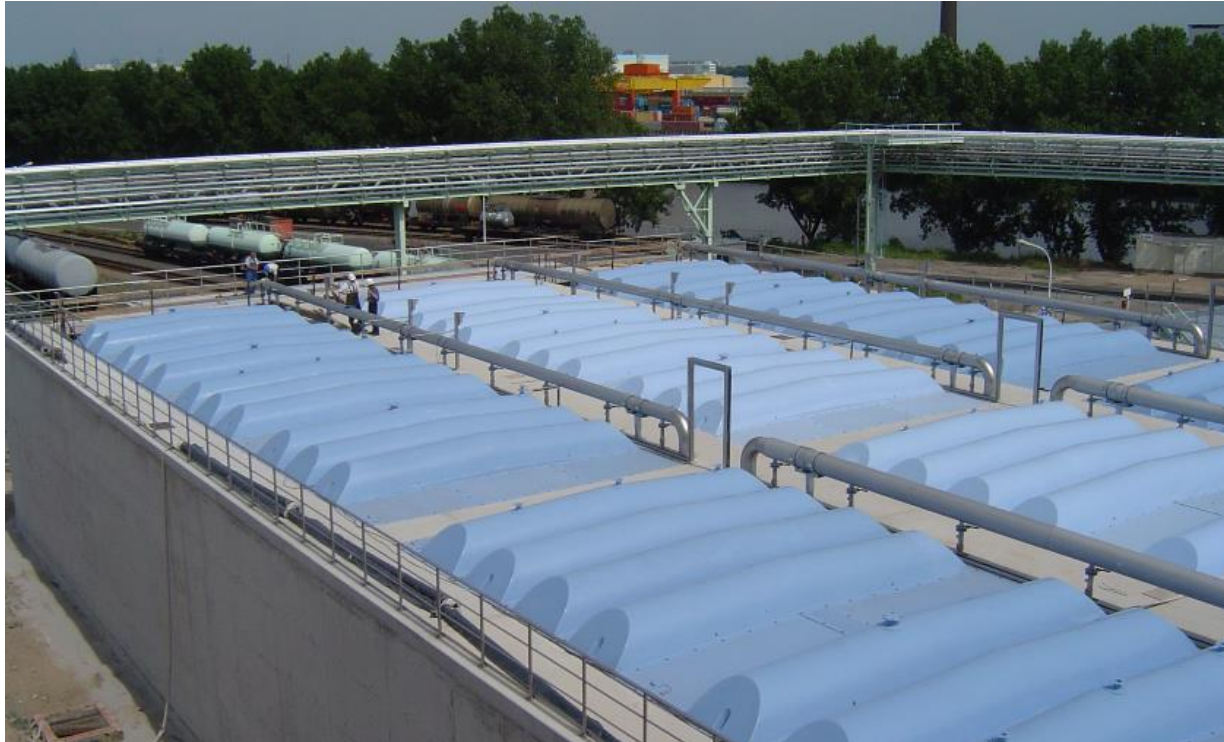
Εικόνα 42: Τυπικός βιολογικός αντιδραστήρας, Πηγή: Ε.Ε.Λ της Ανθούπολης
