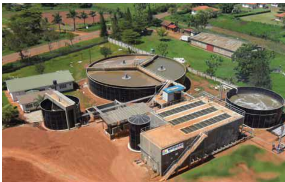
ΕΙΚΟΝΑ 3 ΕΓΚΑΤΑΣΤΑΣΗ ΑΝΑΕΡΟΒΙΑΣ ΧΩΝΕΥΣΗΣ ΥΓΡΩΝ ΑΠΟΒΛΗΤΩΝ [15]
