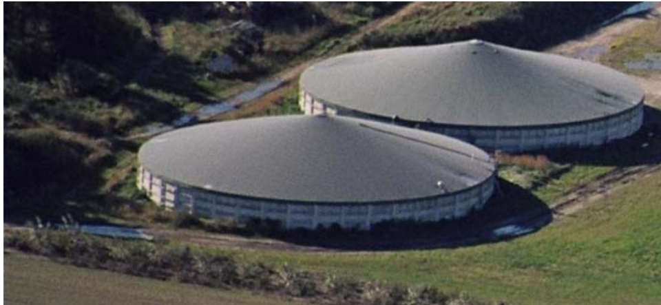
ΕΙΚΟΝΑ 15 ΑΠΟΘΗΚΕΣ ΧΩΝΕΜΕΝΟΥ ΥΠΟΛΕΙΜΜΑΤΟΣ [45]
