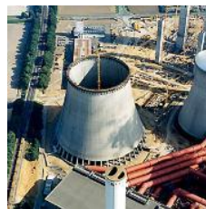
Εικόνα 1.11. Cooling tower, Niederaußem, Germany
