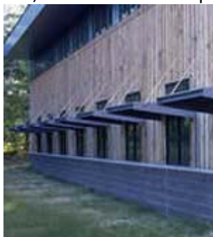
Εικόνα 2.31: Εξωτερικά ράφια φωτισμού, www.cres.gr
