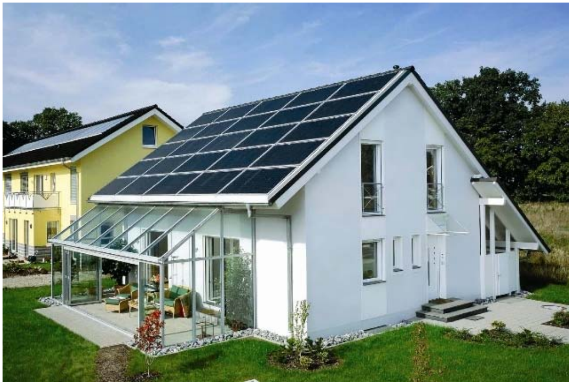
Εικόνα 1.2 : Φωτοβολταϊκά συστήματα παραγωγής ενέργειας σε στέγη κτιρίου, ( http://papachristos.pblogs.gr )
