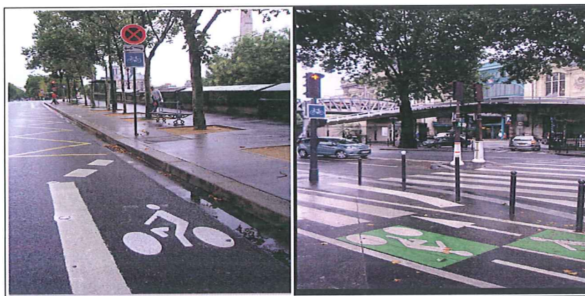
Εικόνα 3.1, Εικόνα 3.2: Σήμανση ποδηλατοδρόμων στην πόλη του Παρισιού
