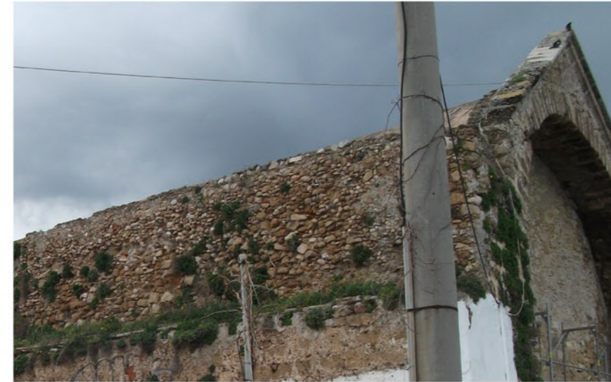
Φωτ. 1 : Αποδιοργάνωση λιθοδομής ανατολικής όψης
