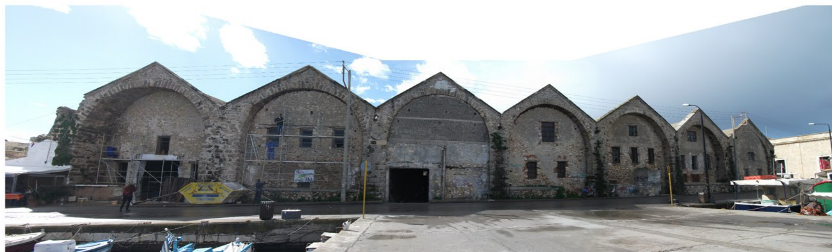
Φωτ. 9 : Βορεινή Όψη Νεωρίων 1,...7
