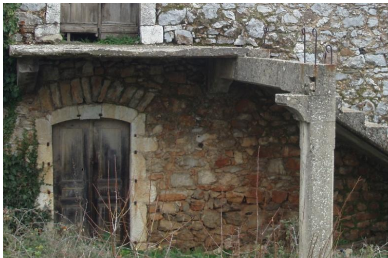
Σχ. 3.2.3.1 Η αμφιέριστη πλάκα, η δοκός πρόβολος, η αμφιέριστη δοκός και το υποστύλωμα
