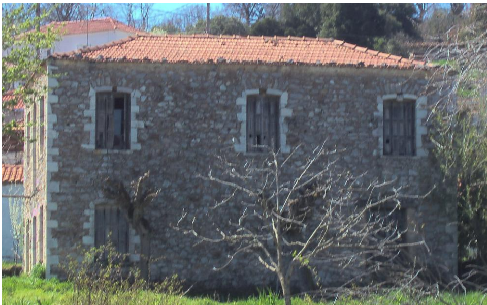
Σχ. 2.3.1 Ανατολική όψη κτηρίου μελέτης
