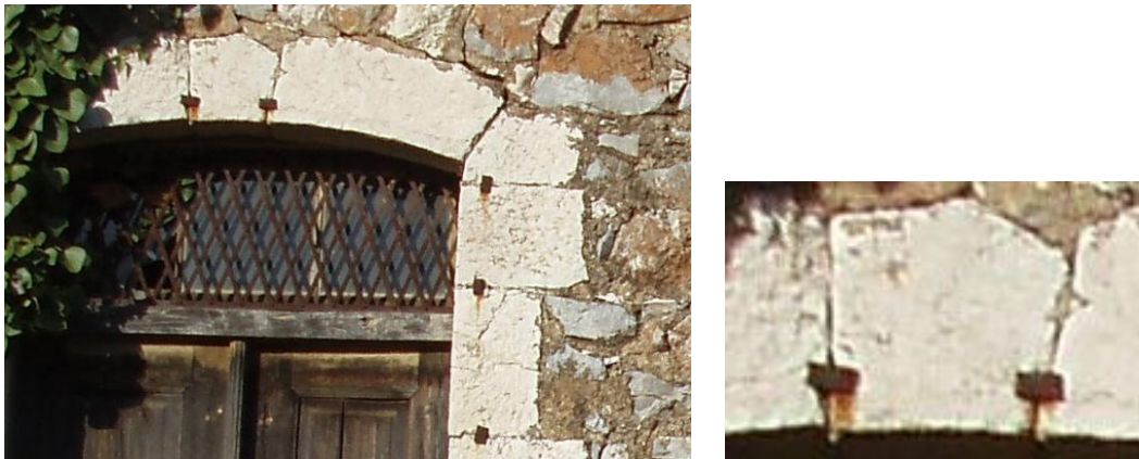
Σχ. 2.4.1 Τζινέτια που συγκρατούν τους λίθους διαμόρφωσης της κεντρικής θύρας του ορόφου
