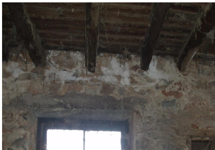
Σχ. 2.6.1 Εμφανές το πάτωμα του ορόφου λόγω απουσίας ταβανιού στο ισόγειο
