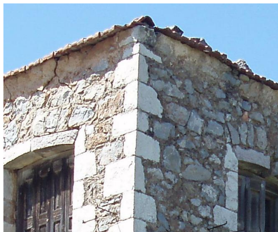
Σχ. 4.1.1 Ακρογωνιαίοι λίθοι και αργολιθοδομή εξωτερικής παρειάς
