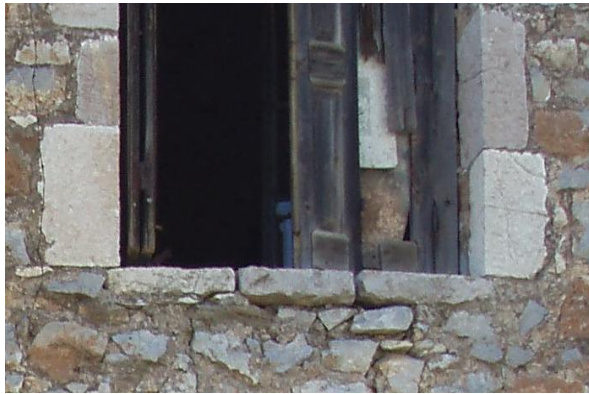
Σχ. 5.3.5 Αποκόλληση λίθων στη ποδιά παραθύρου της νότιας όψης
