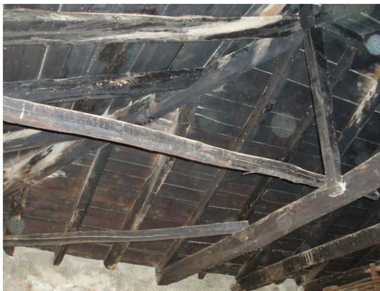
Σχ. 3.2.1.4 Φωτογραφία σκελετού στέγης
