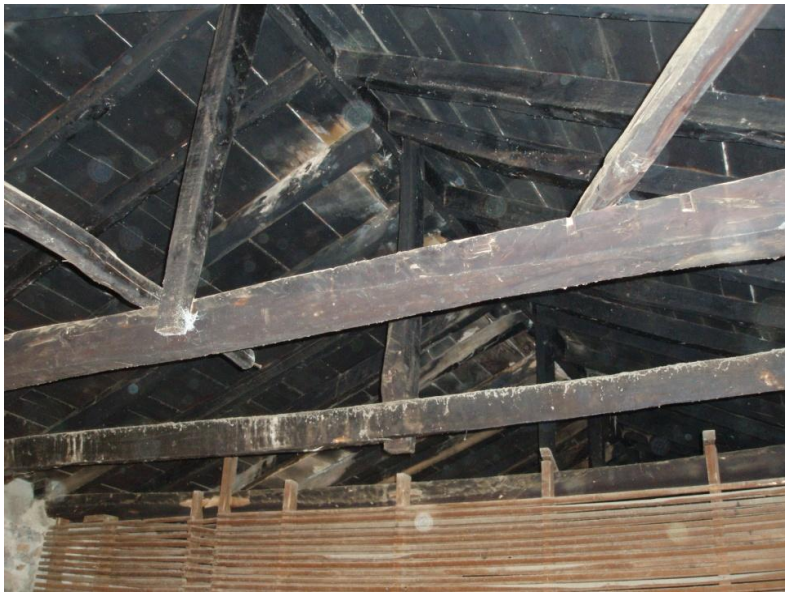
Σχ. 3.2.1.3 Φωτογραφία σκελετού στέγης
