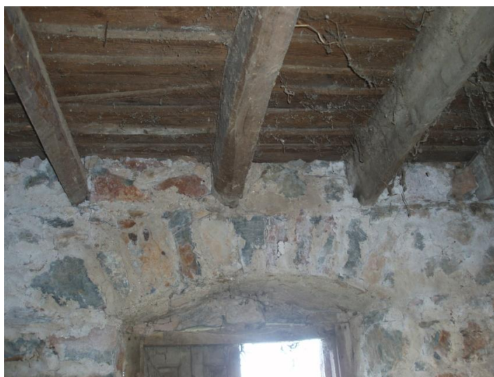
Σχ. 3.2.2.1 Φωτογραφία ξύλινων δοκών πατώματος
