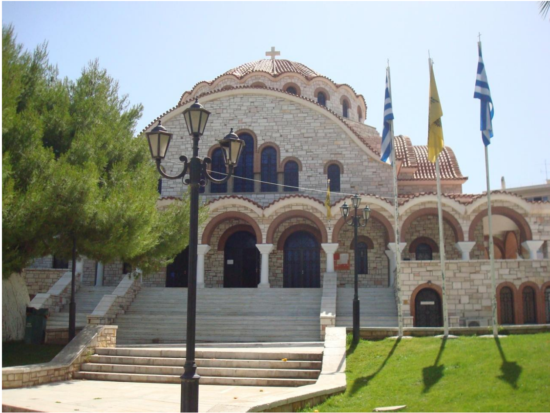
Φωτογραφία 12. Εξωτερική άποψη του ναού.
