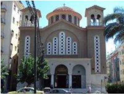
Φωτογραφία 13. Εξωτερική άποψη του ναού.
