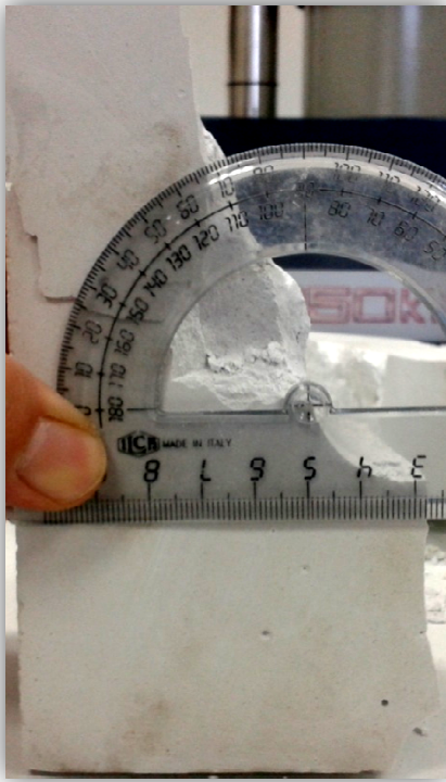
Εικόνα 27 Ρωγμή διάτμησης με κλίση σχεδόν 70°
