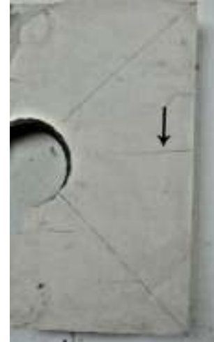
Εικόνα 37 Η εφελκυστική ρωγμή κάμψης
