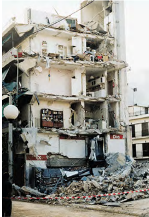
Σχήμα 2.20: Κατεστραμμένο κτίριο από το σεισμό της 7/9/1999 με επίκεντρο την ευρύτερη περιοχή της Πάρνηθας.
