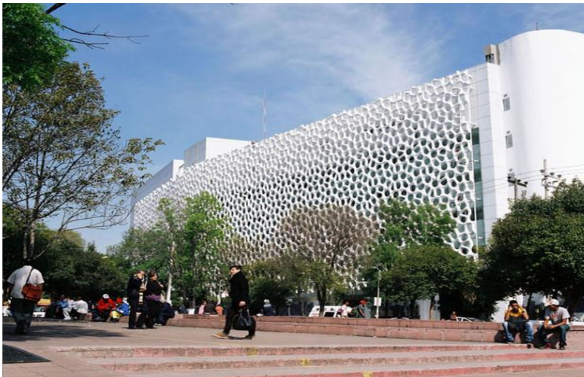
Εικ. 6. Νοσοκομείο στο Μεξικό. Πρόσοψη με αυτοκαθαριζόμενες ιδιότητες, έτος, 2011.[18]
