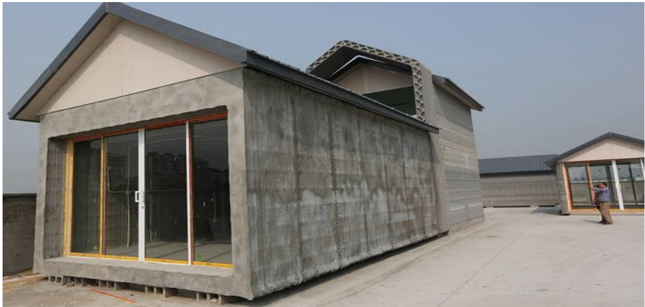
Εικ. 21. Κατοικία κατασκευασμένη μέσω τρισδιάστατης εκτύπωσης από την εταιρεία Winsun, Κίνα.[66]
