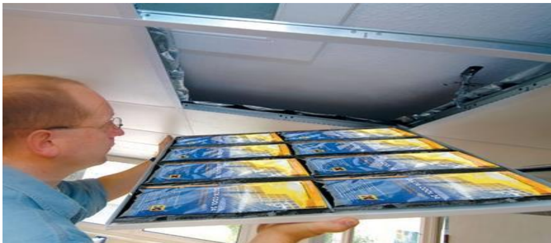
Εικ. 15. ΥΑΦ για αποθήκευση θερμικής ενέργειας σε ταβάνι.[34]
