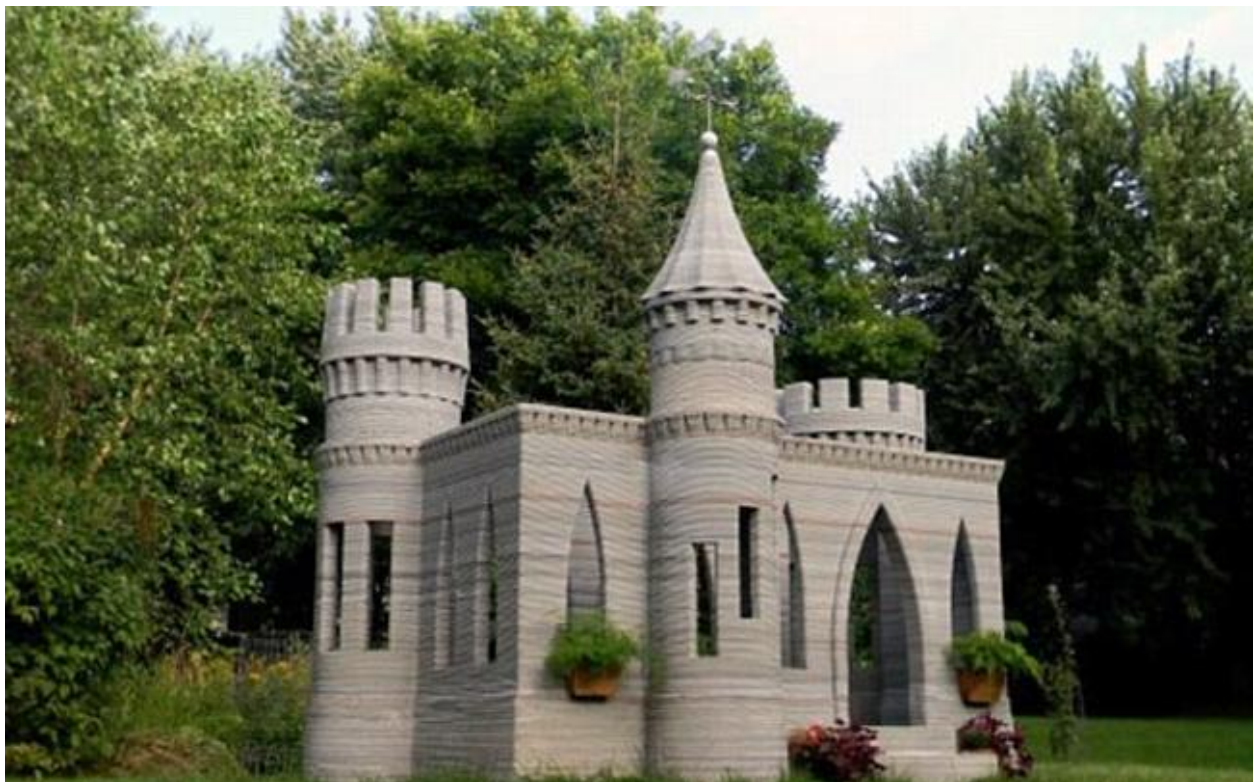
Εικ. 24. Κατασκευή κάστρου μέσω τρισδιάστατης εκτύπωσης και ψηφιακής τεχνολογίας.[72]
