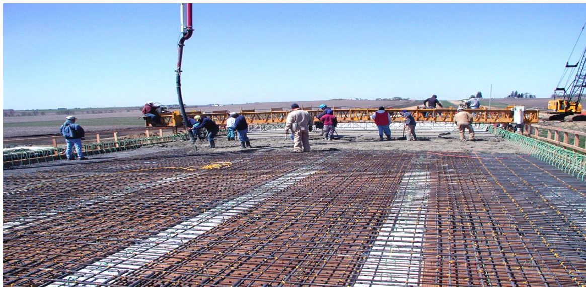
Εικ. 11. Κατάστρωμα γέφυρας στην IOWA, ΗΠΑ, νανοενισχυμένος χάλυβας, έτος 2011.[26]
