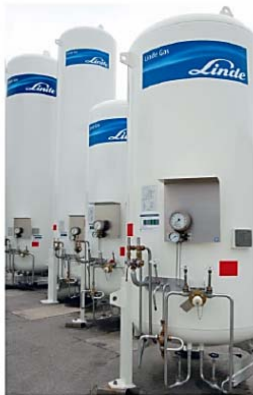
Εικόνα 3.9: Δεξαμενή αποθήκευσης κρυογονικού υδρογόνου της εταιρίας Linde (55. Ιστοσελίδα: www.linde.com )
