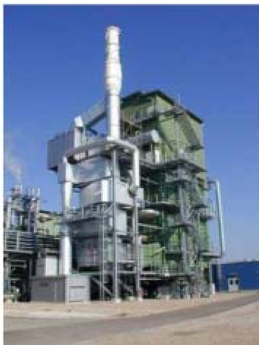
Εικόνα 4.11: Linde-υγραέριο-αναμορφωτής ατμού με CO μετατροπέα (58. Λάμπρου Ε.)
