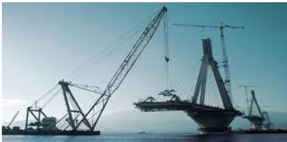
Κατασκευή του καταστρώματος.
