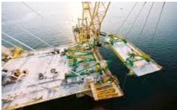
Η κατασκευή του καταστρώματος.
