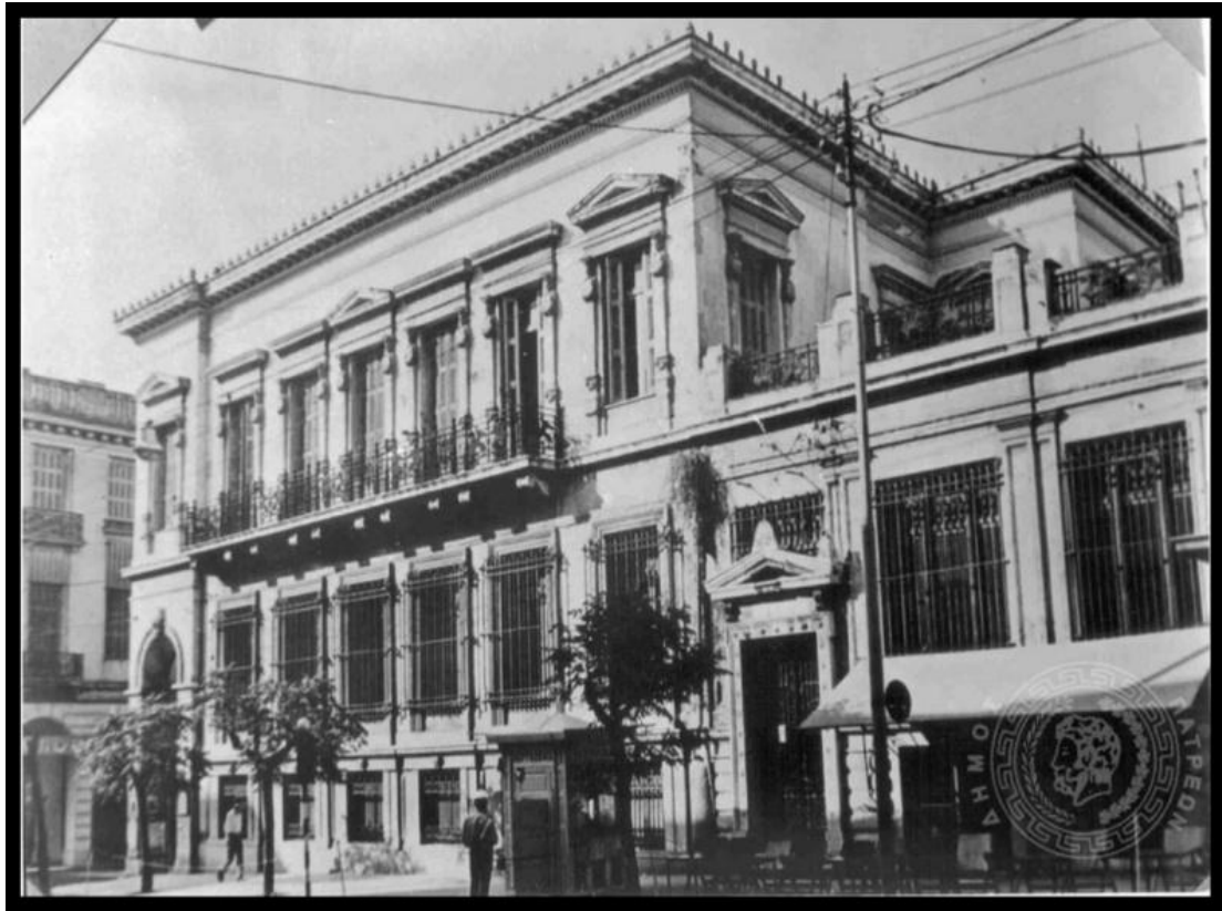
Οικία Χαϊδόπουλου στην Γούναρη και Κορίνθου όπου στεγαζόταν η Εθνική Τράπεζα στις αρχές του 20ού αιώνα, έργο του Σπ.Τζέτζου.
