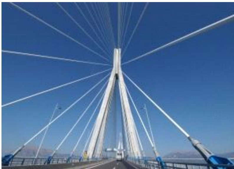
Τα καλώδια ανάρτησης του καταστρώματος.
