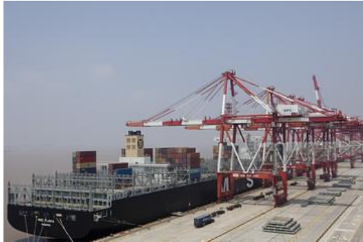
Εικόνα 6: Χώρος κρηπιδώματος σταθμού εμπορευματοκιβωτίων σε λιμένα
