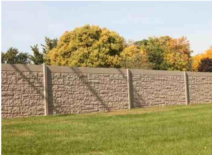
Εικόνα 2.23: Ηχοπετάσματα από τοιχοποιία [13]
