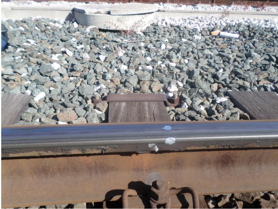
Εικόνα 5.3: Δια χειρός επάλειψη βελτιωτικού τριβής σε τμήμα γραμμής στο αμαξοστάσιο Σεπολίων
