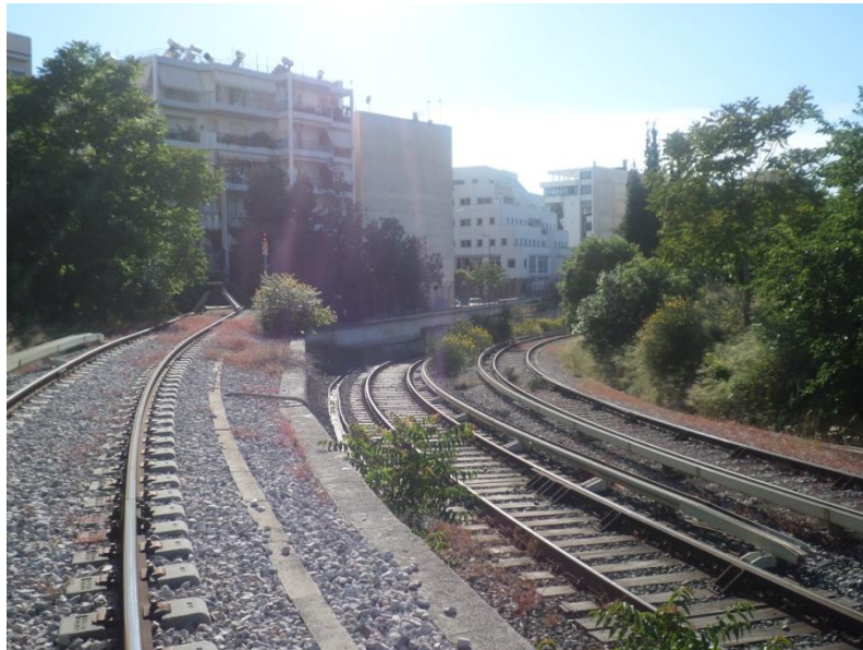
Εικόνα 5.2: Τμήμα γραμμής στο αμαξοστάσιο Σεπολίων
