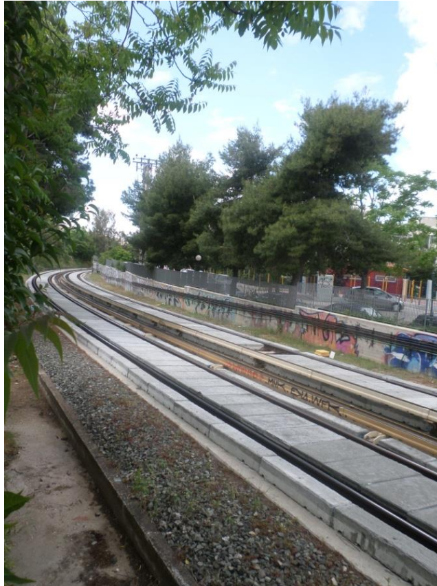
Εικόνα 5.9: Τμήμα γραμμής του δικτύου ΗΣΑΠ στη θέση μέτρησης (Χ.Θ. 18+300) μετά την τοποθέτηση των ηχοαπορροφητικών πλακών (Τρίτη 6 Μαΐου 2014)
