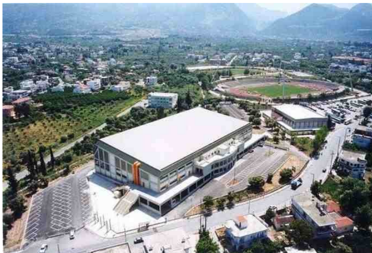
Εικ.3.15 Άποψη από ψηλά του μεταλλικού στεγάστρου του κολυμβητηρίου Α. Πεπανός
