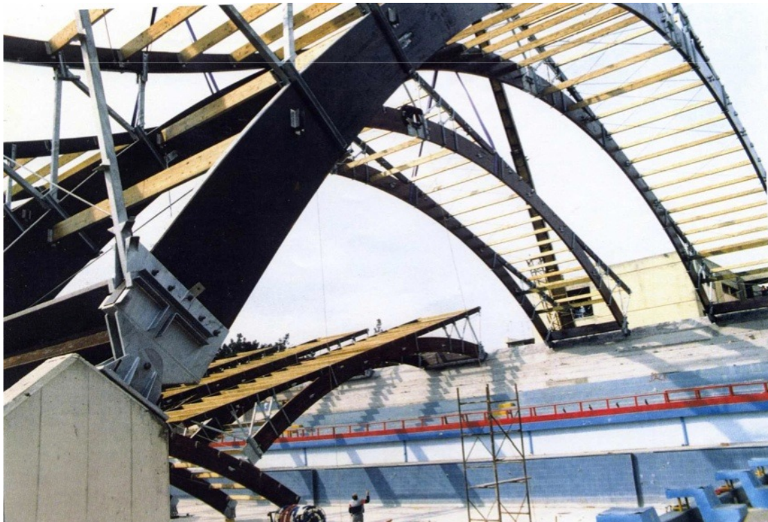
Εικ. 3.10 Κάποια κομμάτια του στεγάστρου έχουν ανεγερθεί και κουμπωθεί έχει ολοκληρωθεί δηλαδή η 2η φάση ενώ τα διπλάνα τους είναι έτοιμα για να ανυψωθούν και να κουμπωθούν με τη βοήθεια του γερανού (απο το αρχείο του καθ. ΕΜΠ Π. Τουλιάτου).
