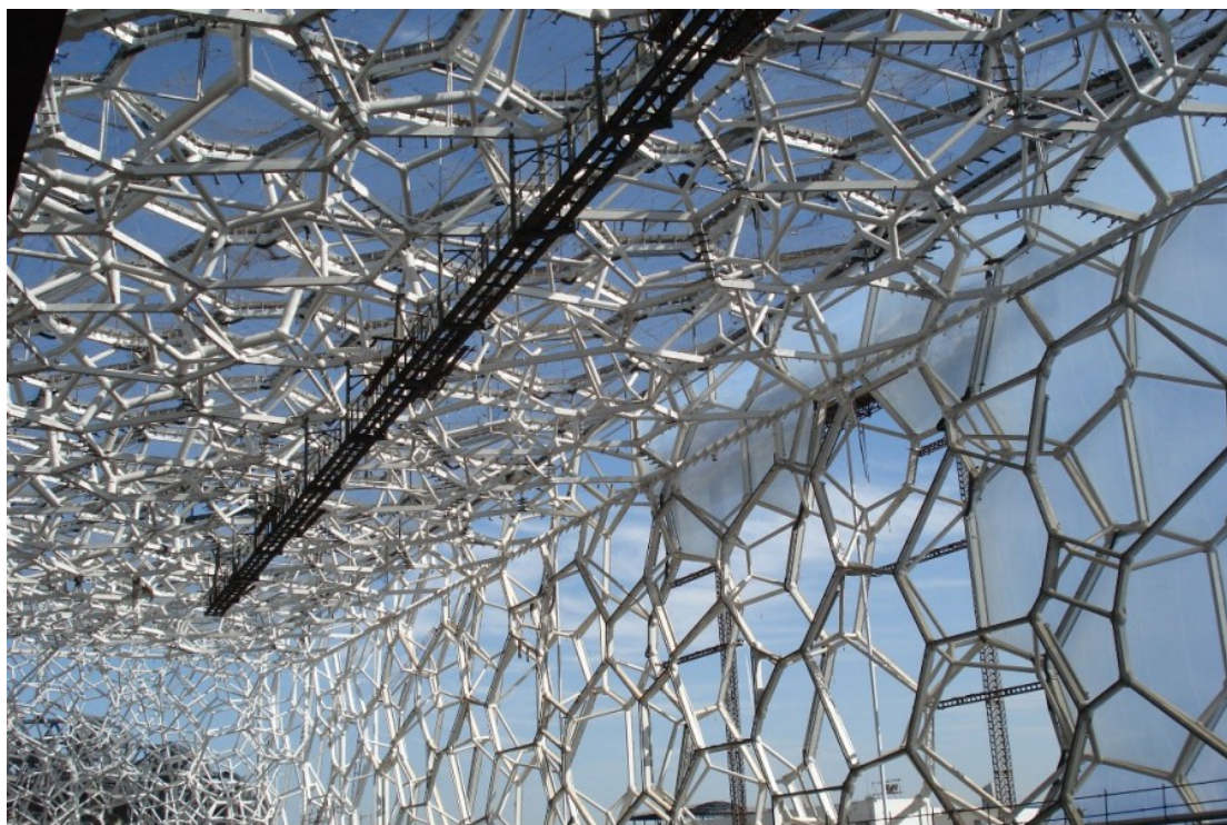
Εικ. 4.10 Άποψη από το εσωτερικό κατά την τοποθέτηση των μεμβρανών ( http://www.arup.com/projects/chinese_national_aquatics_center/watercube_overview_1.aspx )
