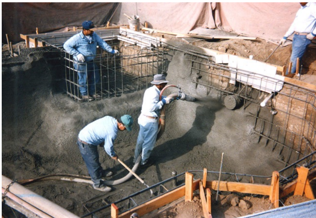
Εικ. 2.5 Ενκολία στη δημιουργία ιδιαίτερων σχημάτων των πισινών από gunite (απο το φωτογραφικό αρχείο εταιρείας Piscines Ideales)
