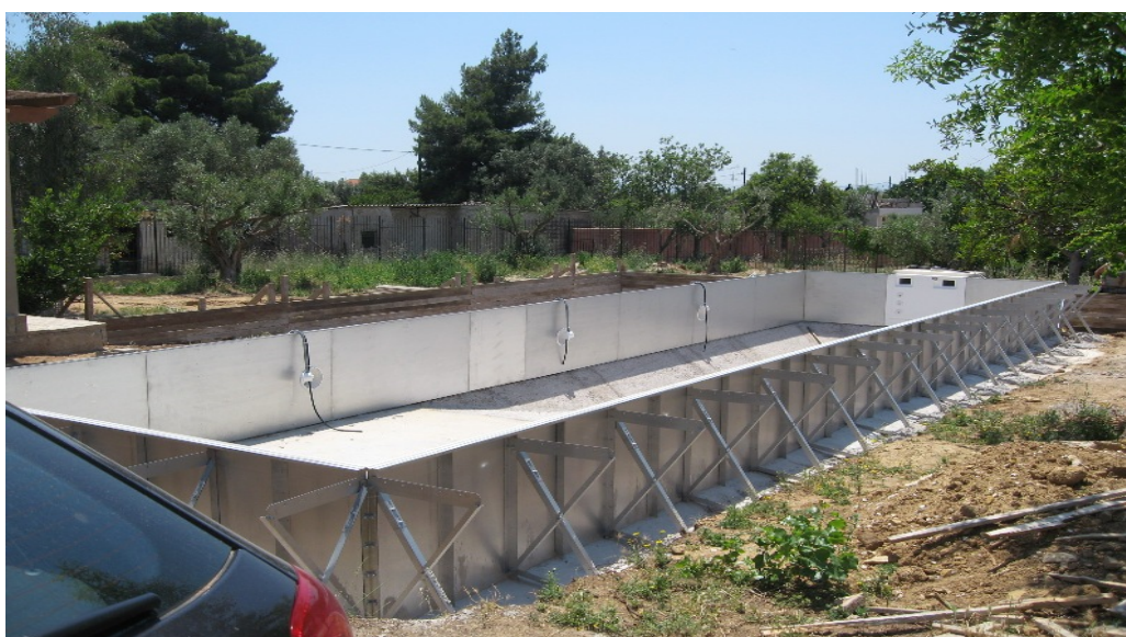
Εικ. 2.6 Πισίνα με περιμετρικά τοιχώματα από μεταλλικά panels (απο το φωτογραφικό αρχείο εταιρείας Piscines Ideales)
