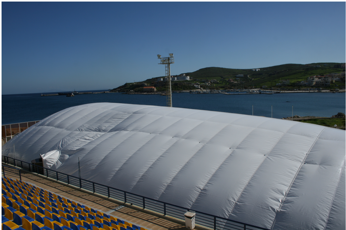
Εικ.3.27 Έναρξη της διαδικασίας πλήρωσης με πεπιεσμένο αέρα, στο εσωτερικό της μεμβράνης (προσωπικό αρχείο).
