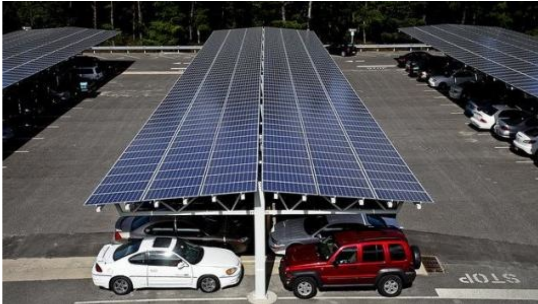
Εικ. 5.3 Φωτοβολταϊκά πλαίσια που καλύπτουν στέγαστρα χώρος στάθμευσης ( http://saveplanet.gr/images/news/solar-parking.jpg )
