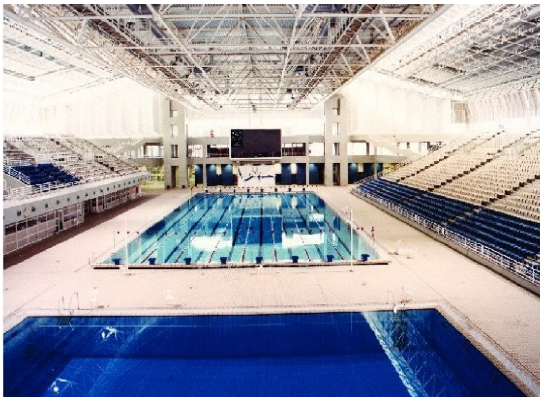
Εικ. 3.13 Γενική άποψη του μεταλλικού στεγάστρου του κλειστού κολυμβητηρίου του OAKA ( http://www.aktor.gr/article.asp?catid=20032&subid=2&pubid=13245101 ).
