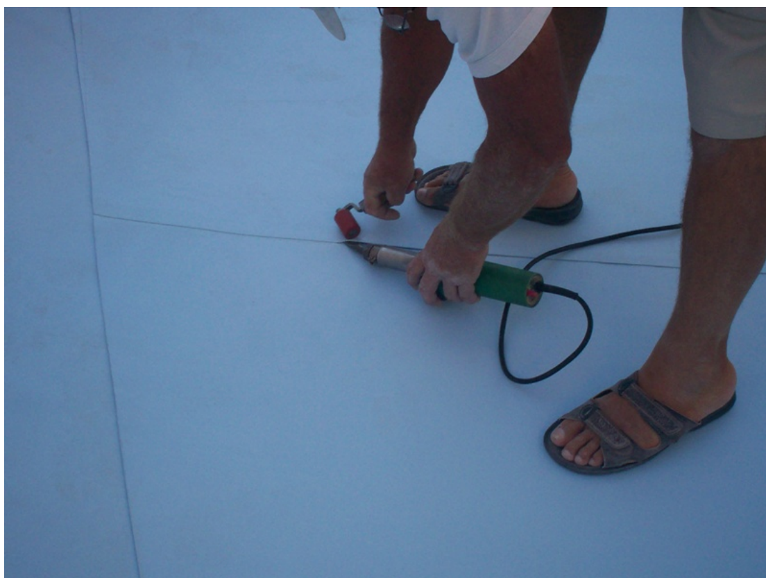
Εικ. 2.7 Συγκόλληση liner (απο το φωτογραφικό αρχείο εταιρείας Piscines Ideales)
