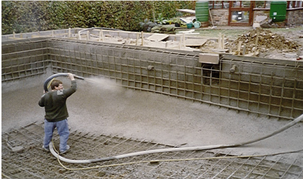
Εικ. 2.4 Σκυροδέτηση κολυμβητικής δεξαμενής απο εκτοξευόμενο σκυρόδεμα (απο το φωτογραφικό αρχείο εταιρείας Piscines Ideales)
