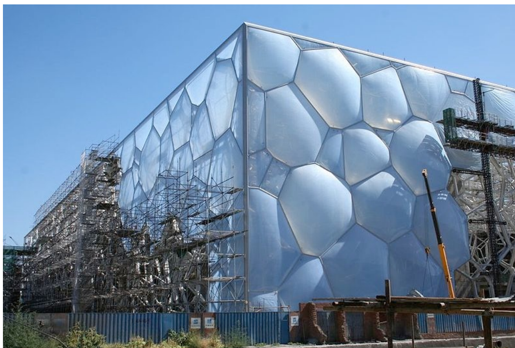
4.11 Σκαλωσιές για την τοποθέτηση των μεμβρανών στα κελιά του χωροδικτύωματος ( http://it.wikipedia.org/wiki/Centro_acquatico_nazionale_di_Pechino#mediaviewer/File:Watercube.jpg )
