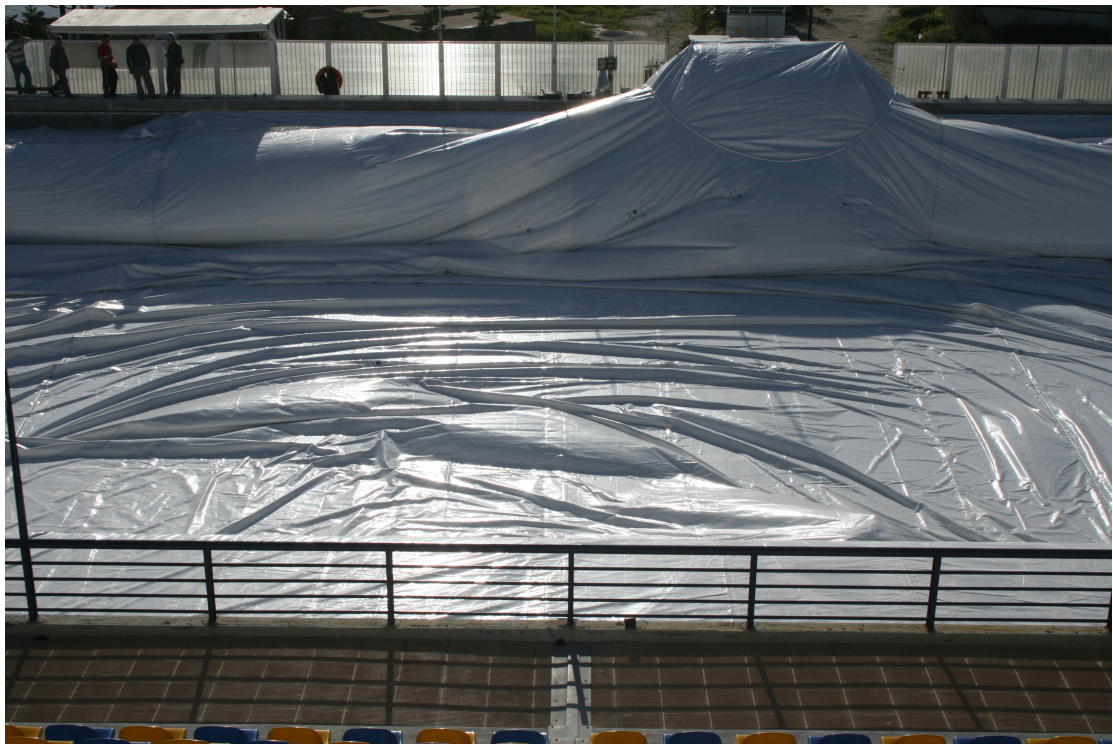
Εικ.3.27 Έναρξη της διαδικασίας πλήρωσης με πεπιεσμένο αέρα, στο εσωτερικό της μεμβράνης (προσωπικό αρχείο).
