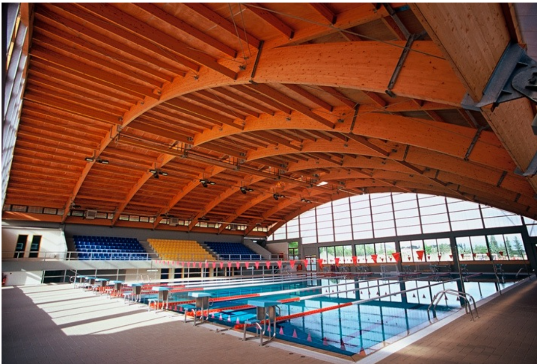
Εικ. 3.4 Κλειστό κολυμβητήριο Κολλεγίου Αθηνών, όπου φαίνεται το ξύλινο στέγαστρο ( http://buildinggreen.gr/sustainable-project/κολυμβητήριο-κολλεγίου-αθηνών-στην-κ-2/ ).
