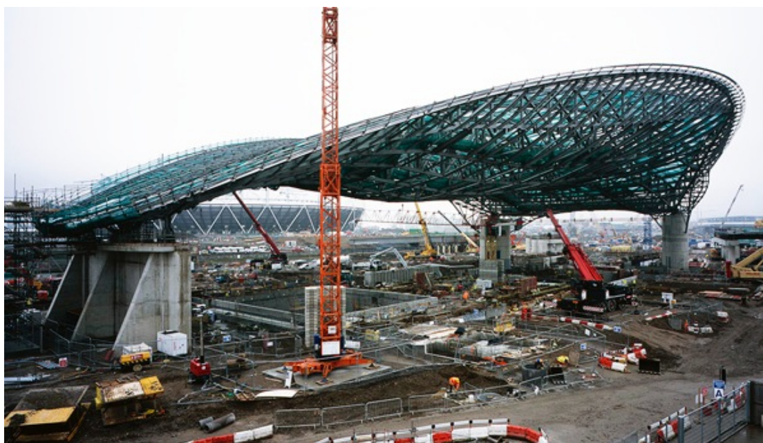
Εικ. 3.19 Μεταλλικό χωροδικτύωμα του στεγάστρου του ολυμπιακού κολυμβητηρίου του Λονδίνου ( http://www.zeroenergybuildings.org/2013/01/blog-post_5.html )
