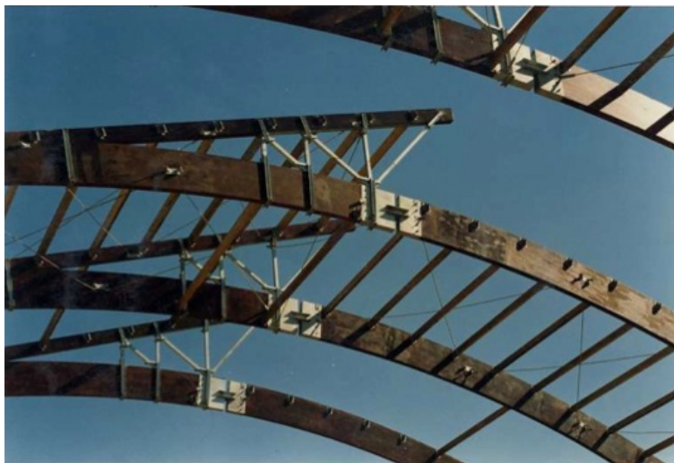
Εικ.3.9 Ευθύγραμμο τμήμα για την δημιουργία ανοιγμάτων αερισμού στην κορυφή του τριαρθρωτού τόξου (απο το αρχείο του καθ. ΕΜΠ Π. Τουλιάτου)
