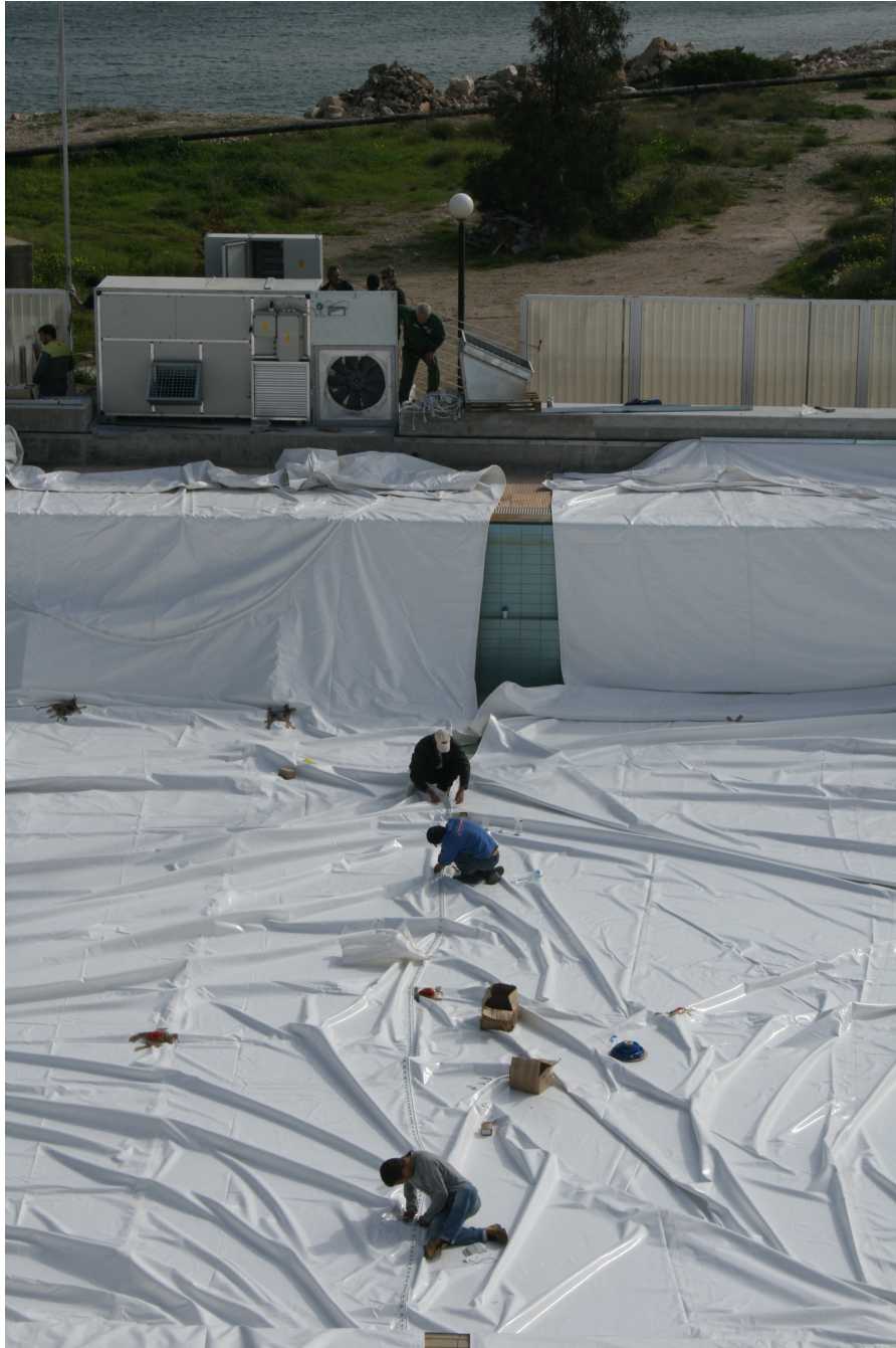
Εικ. 3.26 Ένωση των κομματιών της μεμβράνης απο το εξειδικευμένο συνεργείο. Στο βάθος διακρίνεται η αεροαντλία του συστήματος πεπιεσμένου αέρα και το περιμετρικό τοιχείο με τον μεταλλικό οδηγό πάνω στο οποίο κουμπώνει η μεμβράνη (προσωπικό αρχείο).
