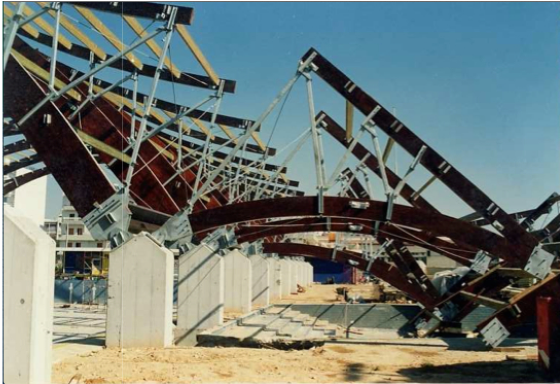
Εικ. 3.7 Στηριξη του δευτερεύοντος μικρού τριαρθρωτού τόξου που θα καλύψει την ρηχή πισίνα εκμάθησης (απο το αρχείο του καθ. ΕΜΠ Π. Τουλιάτου).
