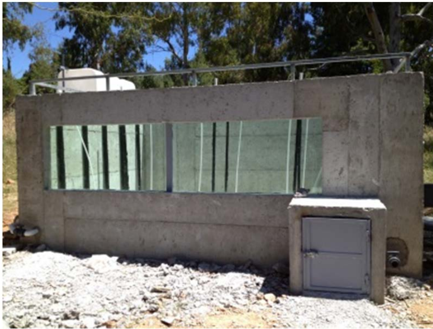
Σχήμα 10.7 Όψεις της δεξαμενής πριν την πλήρωση.
