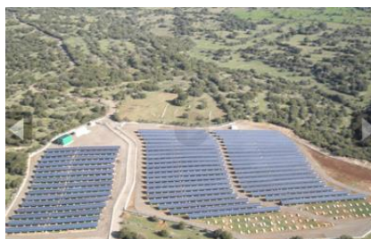
Εικόνα 3.6: Φ/Β Πάρκο στο Δήμο Γορτυνίας
