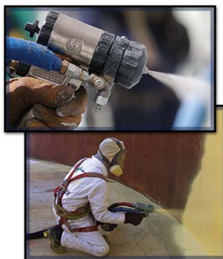
Εικόνα 4.25: Εκτόξευση αφρού πολυουρεθάνης σε καμπύλο δομικό στοιχείο
