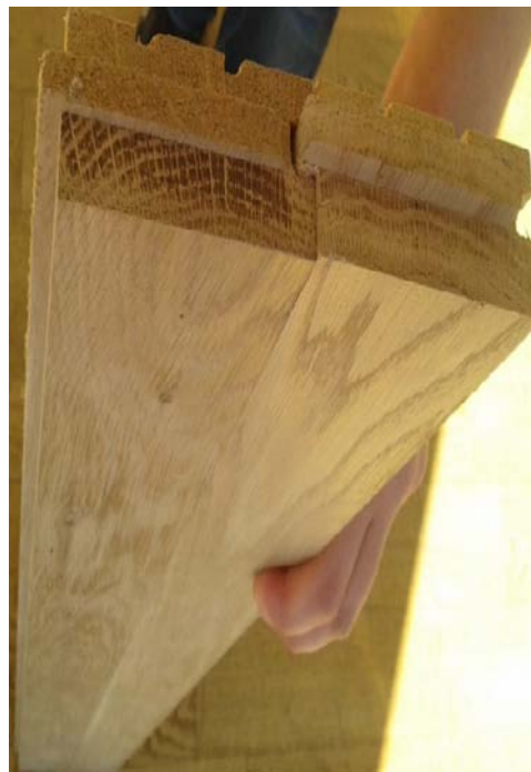
Εικόνα 2.44: Συναρμογή δρύινων παρκέτων ραμποτέ
