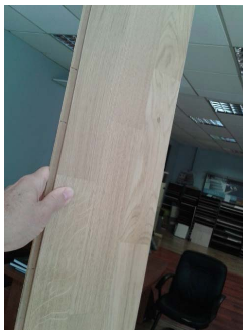
Εικόνα 2.48: Η εμφανής (πάνω) όψη προγουλισμένης ξύλινης λωρίδας (στρώση ακριβού ξύλου)
