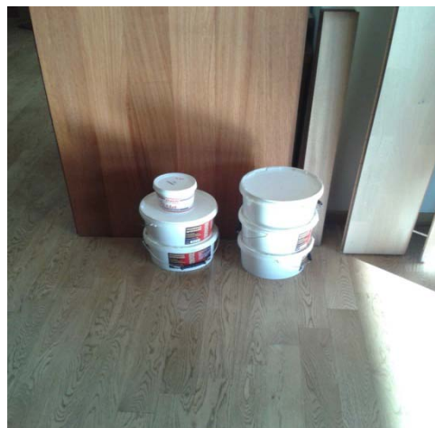
Εικόνα 2.50: Ξυλόκολλα κρυσταλλίζε για τη συγκόλληση του προγαλισμένου ξύλινου δαπέδου
