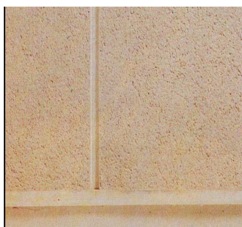
Εικόνα 3.46: Τρίτη στρώση επιχρισματος (τελική) τύπου αρτιφισιέλ
