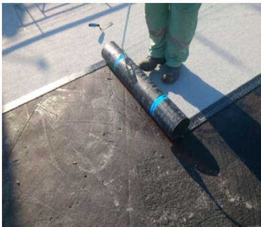
Εικόνα 4.52: Τοποθέτηση μόνωσης δώματος από ασφαλτόπανο
