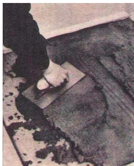
Εικόνα 2.26: Τοποθέτηση πλακιδίων με τσιμεντοκονίαμα (πηγή [12] )
