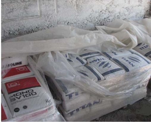
Εικόνα 3.36: Σάκκοι έτοιμοι σοβά και λευκού τσιμέντου προφυλαγμένοι από την υγρασία με φύλλο ναύλον και εδραζόμενοι πάνω σε ξύλινη παλέτα εντός στεγασμένου αποθηκευτικού χώρου
