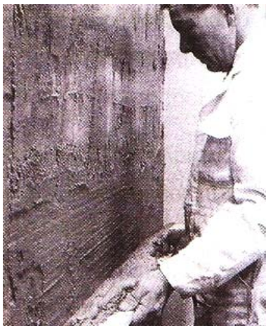
Εικόνα 3.41: Ανάσυρση μεταλλικού πήχου για τη διάστρωση του κονιάματος της δεύτερης στρώσης
