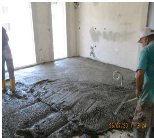
Εικόνα 4.44: Φελομπετόν, θερμομονωτικό ελαφροσκυρόδεμα με βάση τη διογκωμένη πολυστερίνη, ηχομονωτικό, κατάλληλο για γεμίσματα και υπερύψωση δαπέδων και υπόστρωμα τσιμεντοκονίας (πηγή: διαδίκτυο)
