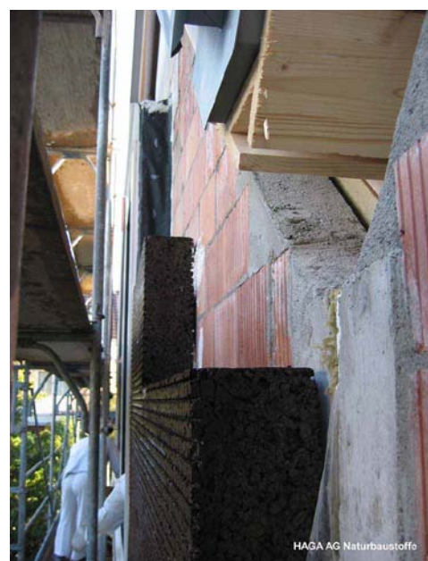
Εικόνα 4.20: Εξωτερική θερμομόνωση με πλάκες φελλού
