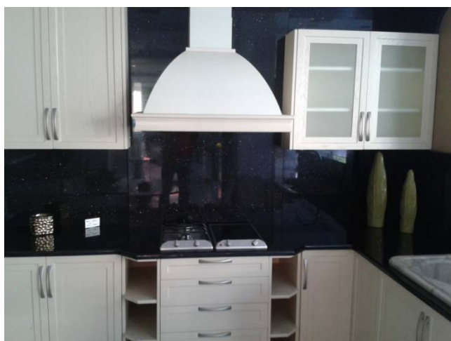
Εικόνα 3.4: Επένδυση τοίχου πάγκου κουζίνας με πλάκες χαλαζία
