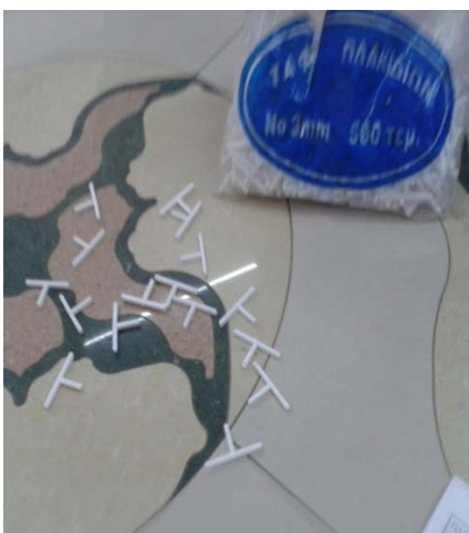
Εικόνα 2.19: Πλαστικά ταφ περάτων αρμών Κατά την τοποθέτηση κεραμικών πλακιδίων δαπέδου και τοίχου
