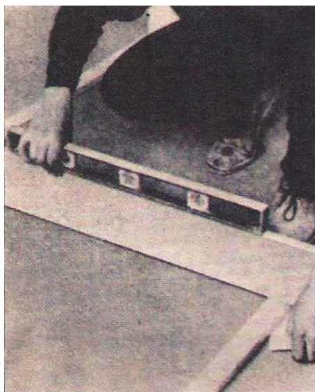
Εικόνα 2.25: Αλφάδιασμα χώρου που θα τοποθετηθούν τα πλακίδια (πηγή [12] )
