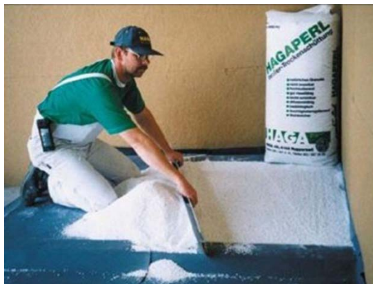
Εικόνα 4.27: Εφαρμογή μόνωσης δαπέδου με χυτό περλίτη
