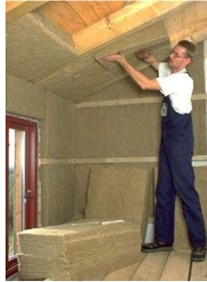
Εικόνα 4.33: Τοποθέτηση θερμομονωτικών πλακών λιναριού
