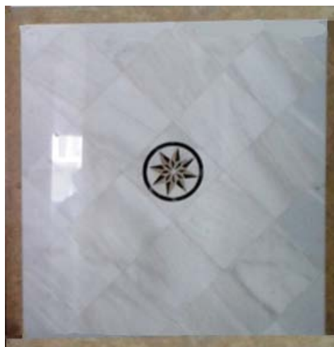
Εικόνα 2.33: Δάπεδο με μάρμαρο Πεντέλης (Διονύσου) με παράσταση και περιμετρική μπορντούρα από χρωματιστό μάρμαρο
