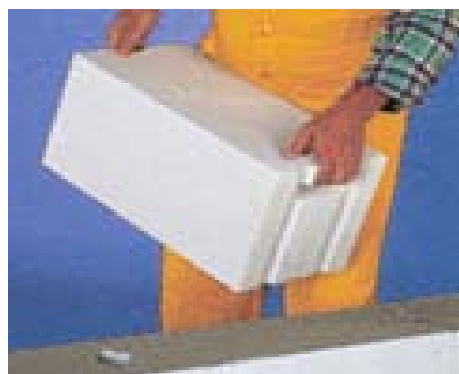
Εικόνα 4.30: Τούβλο από αεριομπετόν τύπου YTONG block (πηγή: διαδίκτυο)
