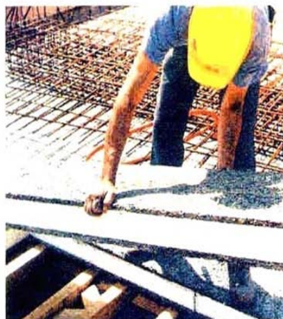
Εικόνα 4.37: Μόνωση στην κάτω πλευρά της πλάκας τοποθετημένη στον ξυλότυπο πριν τη σκυροδέτηση (πηγή: http://www.metaxiotis.gr/ )
