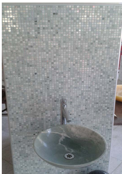
Εικόνα 3.5: Επένδυση τοίχου λουτρού με πλακίδια μαρμάρινου ψηφιδωτού
