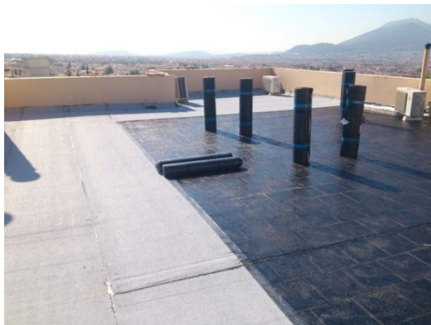
Εικόνα 4.53: Τοποθέτηση μόνωσης δώματος από ασφαλτόπανο
