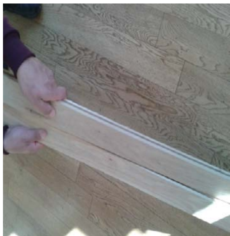
Εικόνα 2.49: Συναρμογή ξύλινων προγαλισμένων λωρίδων ραμποτέ
