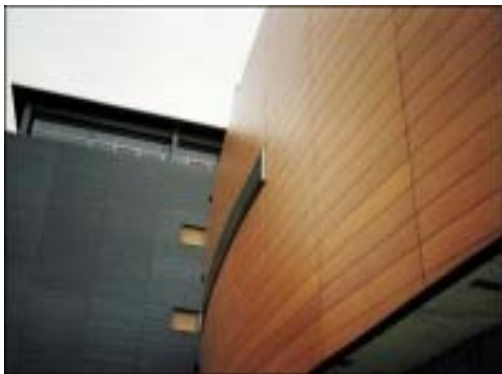
Εικόνα 3.47: Ξύλινη επένδυση εξωτερικού και εσωτερικού χώρου αντίστοιχα
