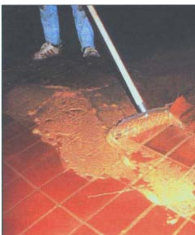
Εικόνα 2.15: Πλήρωση αρμών με αριάνι
