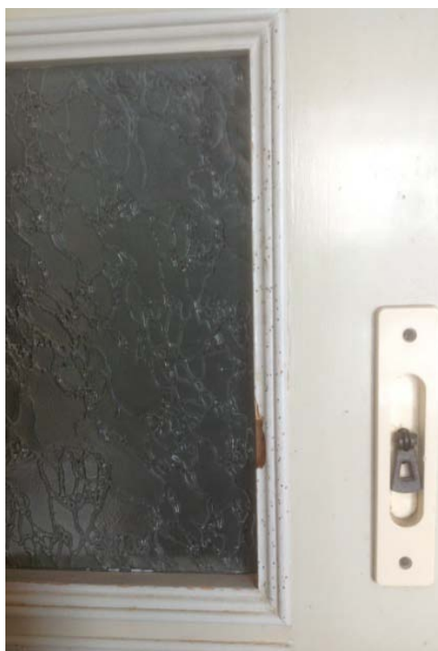
Εικόνα 2.42: Αποτελέσματα παρουσίας μικροοργανισμών (σαράκι) στο ξύλο
