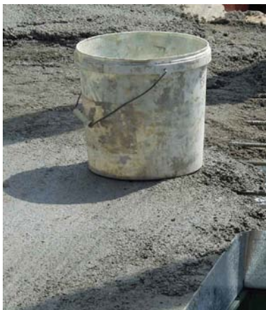
Εικόνα 4.31: Κατασκευή από περλιτομπετόν
