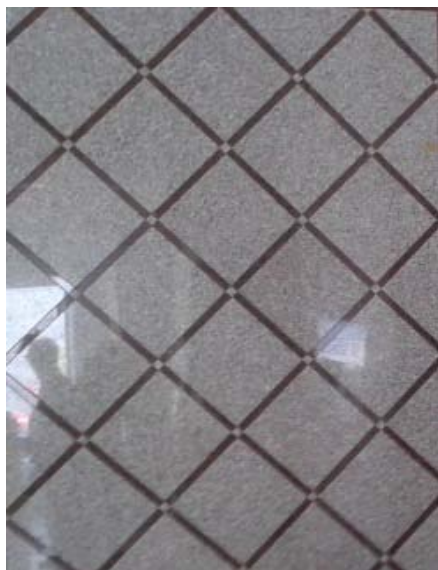
Εικόνα 2.34: Δάπεδο με τυποποιημένες πλάκες φυσικού γκρίζου γρανίτη 30x30 με φιλέτα πλάτους 2 cm και τάκους 2x2 από κοκκινωπό επίσης φυσικό γρανίτη
