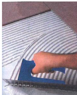
Εικόνα 2.13: Διάστρωση κόλλας με οδοντωτή σπάτουλα
