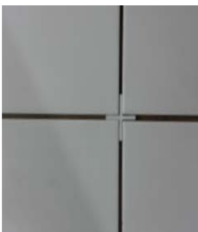
Εικόνα 2.19: Πλαστικά ταφ περάτων αρμών Κατά την τοποθέτηση κεραμικών πλακιδίων δαπέδου και τοίχου
