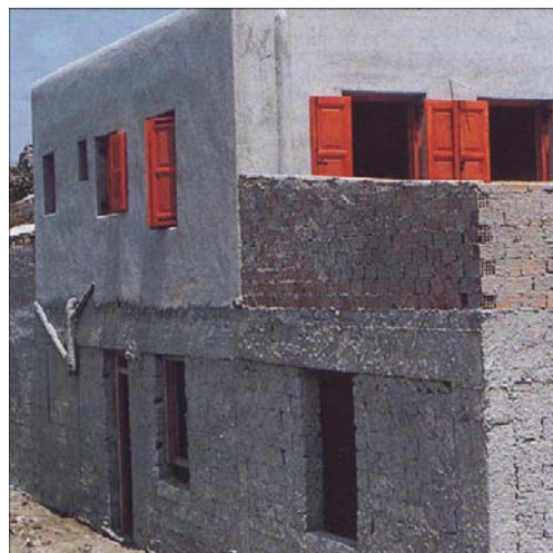
Εικόνα 3.40: Πρώτη στρώση επιχρίσματος (πεταχτό)
