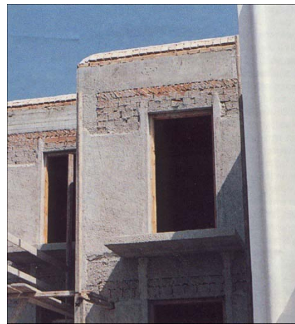
Εικόνα 3.42: Δεύτερη στρώση επιχρίσματος (λάσπωμα)
