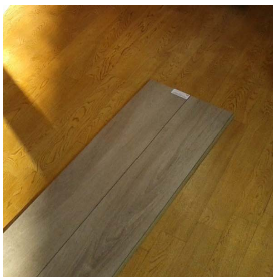
Εικόνα 2.57: Δυο λωρίδες laminate πάνω σε δρύινο καρφωτό δάπεδο
