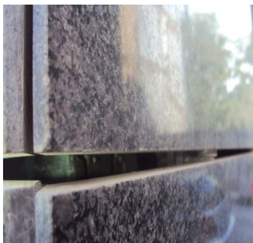
Εικόνα 3.12: Λεπτομέρειες ορθομαρμάρωσης σε κτήριο γραφείων
