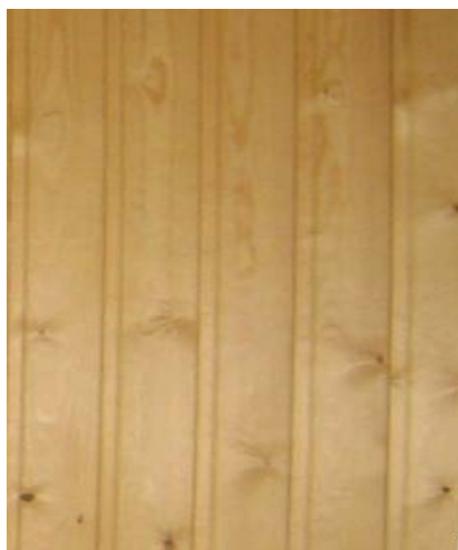
Εικόνα 3.48: Επένδυση τοίχου με λωρίδες ραμποτέ από πεύκο
