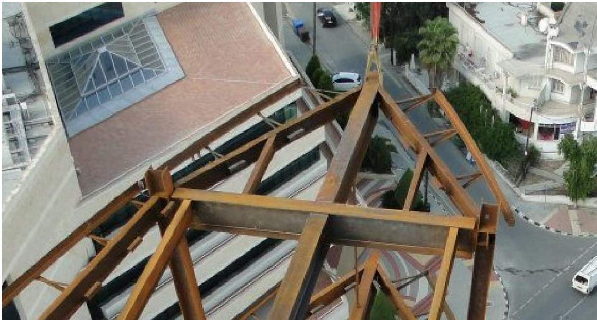
Εικόνα 3.3 Ισοσταθμία κυρίων και δευτερευουσών δοκών. Φωτογραφία από τη φάση της κατασκευής του κτιρίου.
