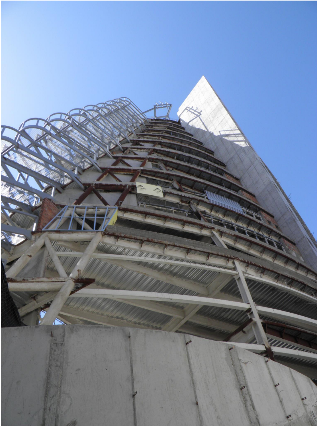
Εικόνα 2.8 Νότια όψη του κτιρίου. Διακρίνεται η σύμμικτη πλάκα του μηχανολογικού ορόφου με το τραπεζοειδές μεταλλικό έλασμα, ο ημιώροφος, το τμήμα από οπλισμένο σκυρόδεμα του φέροντος οργανισμού καθώς και τα διαγώνια μέλη κυκλικής διατομής E(CHS 323.9mm/12.5mm ), Q(CHS 273mm/10mm ) και S(CHS 219.8mm/8mm )
