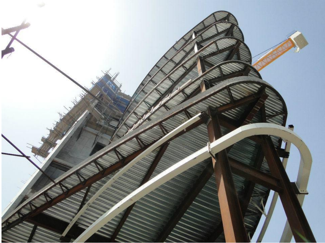
Εικόνα 2.8 Λεπτομέρεια της σύμμικτης πλάκας. Το τελικό σχήμα της καμπύλης της πλάκας δημιουργείται με γωνιακά RSA(150mm x100mm x10 mm) τα οποία στηρίζονται στην εσχάρα των κυρίων δοκών.
