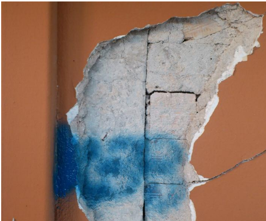
Φωτογραφία 24: Υποσύλωμα Κ33. Βλάβη βαθμού Β2 (α).
