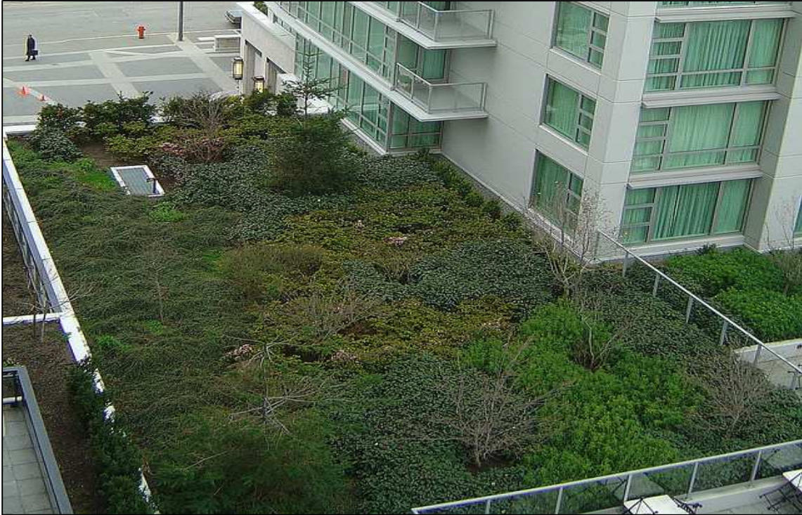
Εικόνα 2-17: Μειώνοντας τον αντίκτυπο των αδιαπέραστων επιφανειών: Πράσινη οροφή στο The Marriott Hotel, Victoria, BC, Canada
