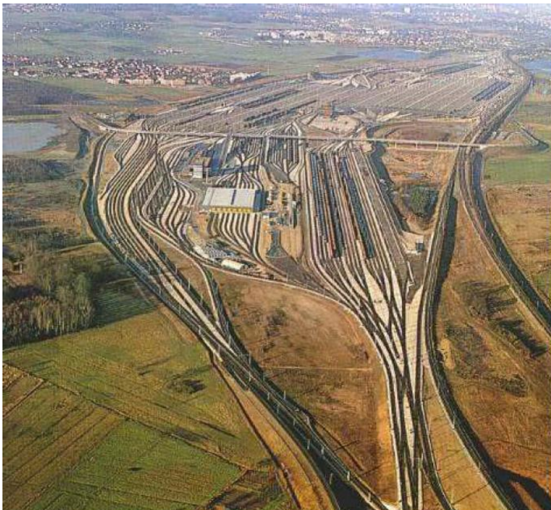
Γενική Άποψη Σιδηροδρομικού Εμπορευματικού Σταθμού Mashen, Ολλανδία.
