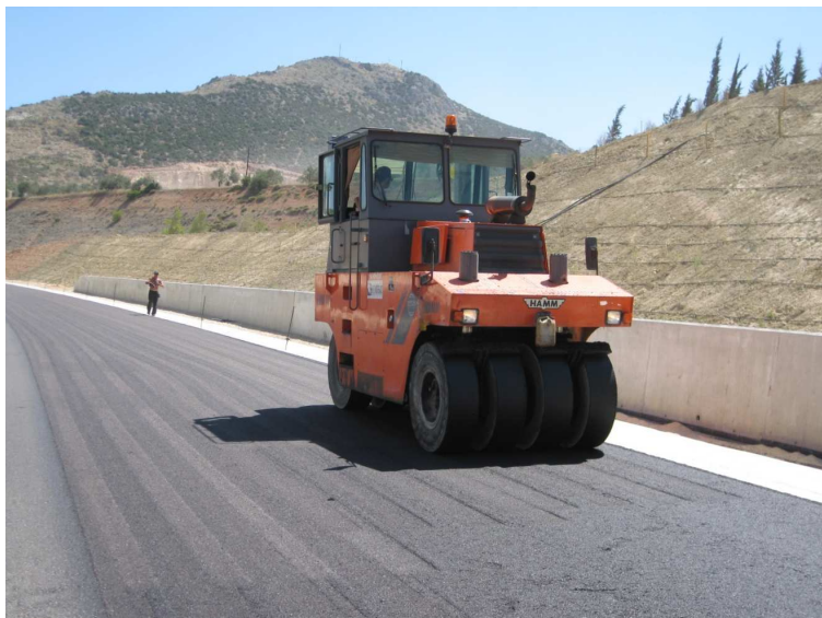
Σχήμα 4.9 Συμπύκνωση ασφαλτομίγματος με λαστιχοφόρο οδοστρωτήρα
