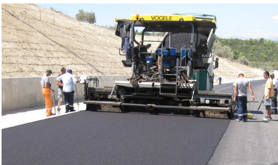
Σχήμα 4.8 Διαστρωτήρας (Finisher) ασφαλτομιγμάτων
