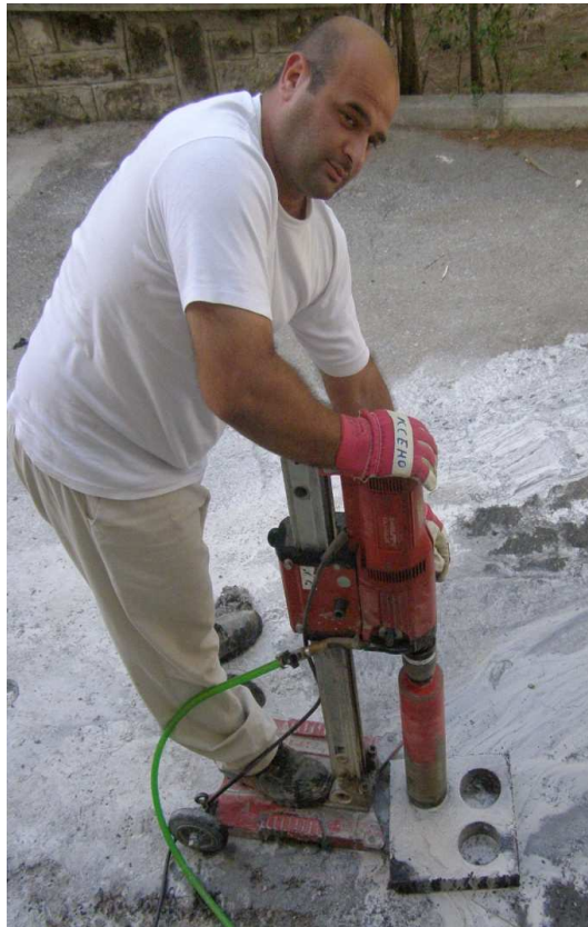
Σχήμα 6.8 Εξαγωγή πυρήνων
