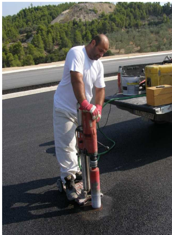
Σχήμα 4.12 Εξαγωγή πυρήνων στο διαστρωθέν τμήμα της αρτηρίας
